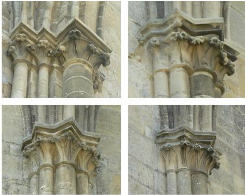
Il. 133. Ruinas de la iglesia abacial de Royaumont. Detalle de los capiteles del muro sur
