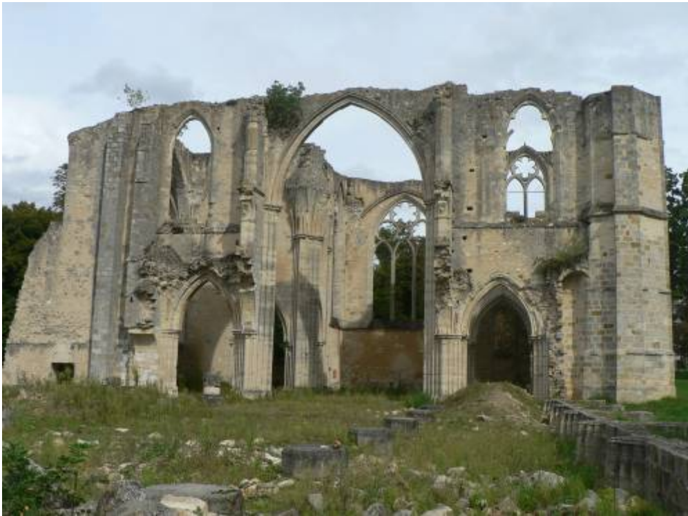
Il. 209. Ruinas de la iglesia abacial de Lys con la torre a la derecha
