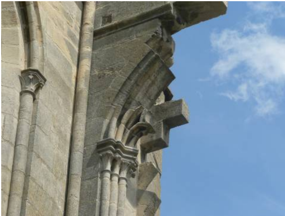
Il. 122. Ruinas de la iglesia abacial de Royaumont. Torrecilla del brazo norte del transepto. Detalle del nivel del triforio con los arquillos polilobulados
