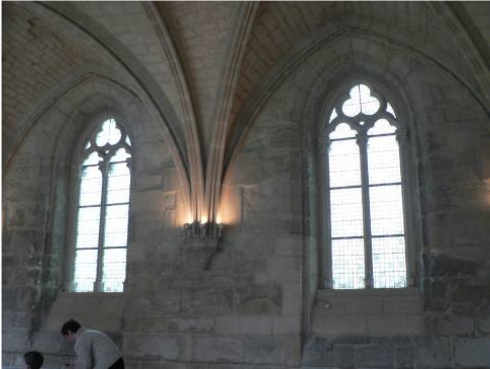
Il. 129. Abadía de Maubuisson, sala capítular. Detalle de las ventanas del muro oriental
