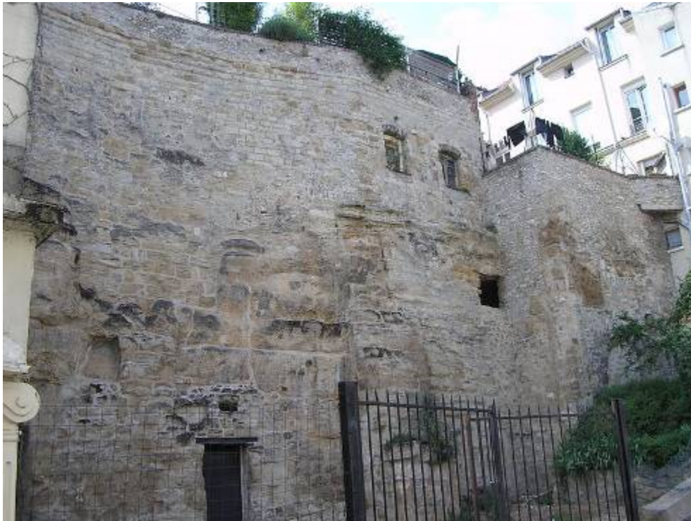
Il. 258. Castillo de Pontoise. Restos de la muralla defensiva
