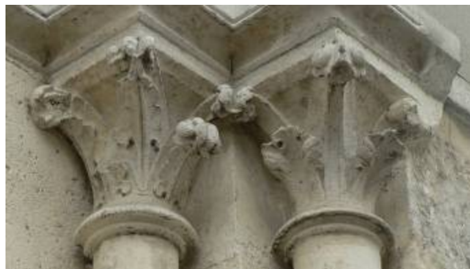
Il. 229. Hospital de Louvres. Detalle de los capiteles del lado derecho
