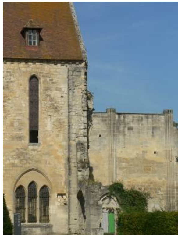
Il. 176. Aspecto externo de la abadía de Royaumont, panda oriental del claustro en ángulo con el brazo sur del transepto. También se ve la puerta del siglo XIII
