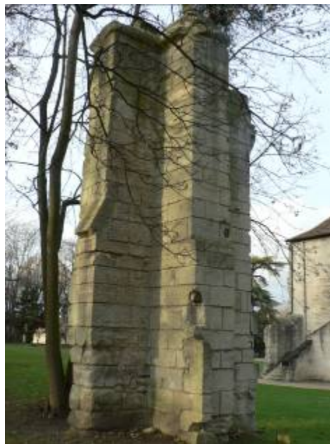
II. 192. Ruinas de la iglesia abacial de Maubuisson. Ángulo sureste de la capilla de san Juan Evangelista
