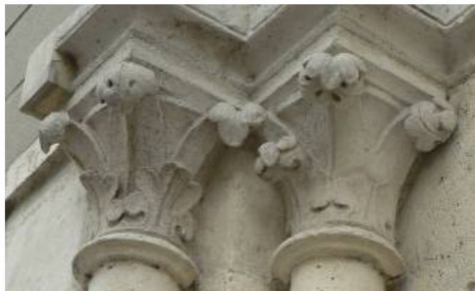
Il. 228 Hospital de Louvres. Detalle de los capiteles del lado izquierdo
