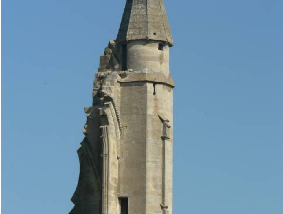
Il. 117. Ruinas de la iglesia abacial de Royaumont. Detalle de los restos de la torrecilla del brazo norte del transepto donde se aprecia el claristorio con el arco externo decorado con puntas de diamante
