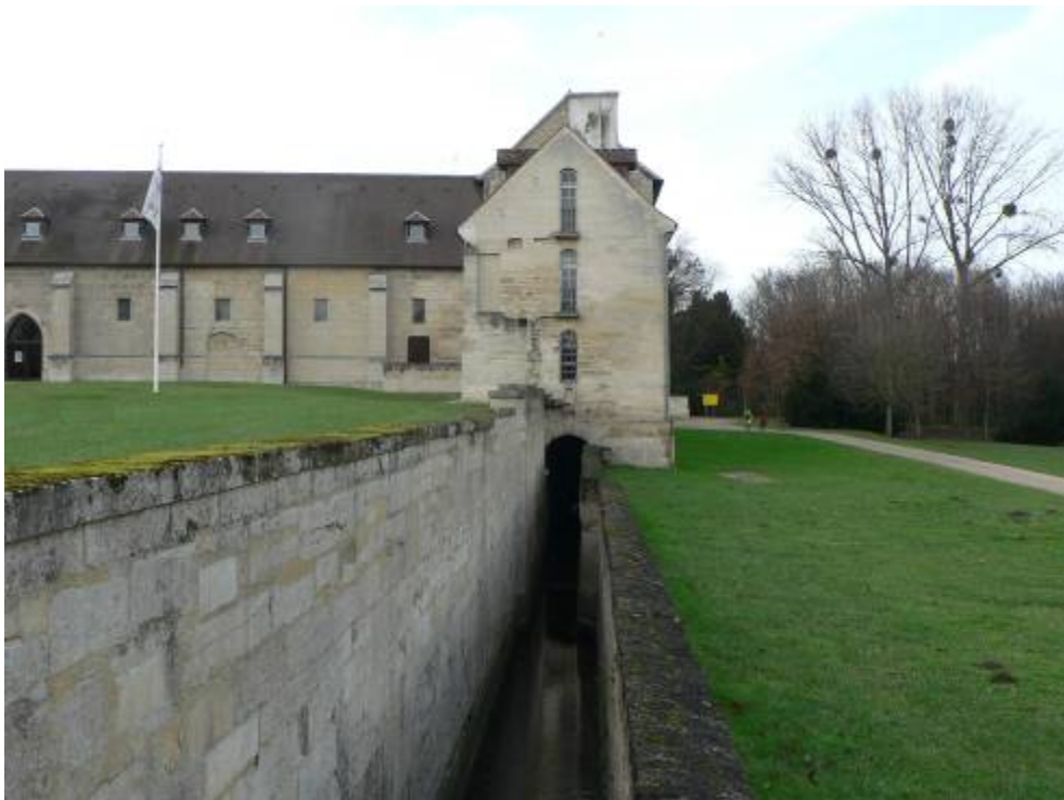
Il. 198. Abadía de Maubuisson. Letrinas, vista desde el Este, en perpendicular a la panda oriental del claustro
