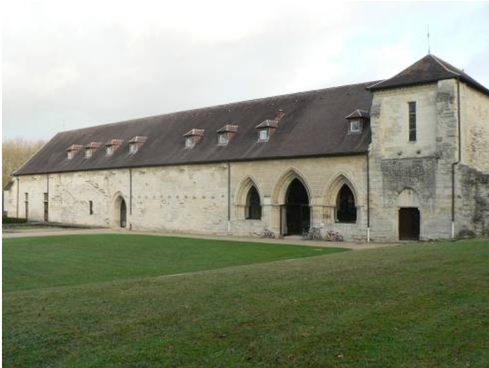
Il. 54. Abadía de Maubuisson. Vista de la panda oriental desde el interior del claustro
