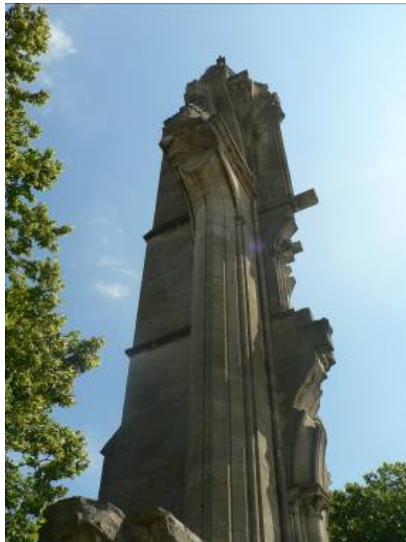
Il. 116. Ruinas de la iglesia abacial de Royaumont. Detalle de los restos de la torrecilla del brazo norte del transepto donde se aprecia el alzado triple
