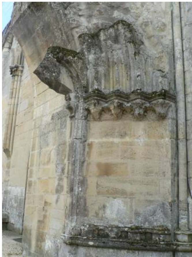
Il. 172. Ruinas de la iglesia abacial de Royaumont. Restos del pórtico occidental de la iglesia
