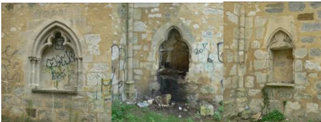
II. 157. Piscinas de la cabecera de la iglesia abacial de Lys
