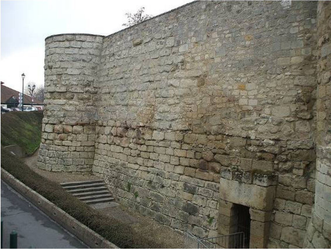
Il. 238. Ruinas del castillo de Beaumont-sur-Oise. Vista de la muralla
