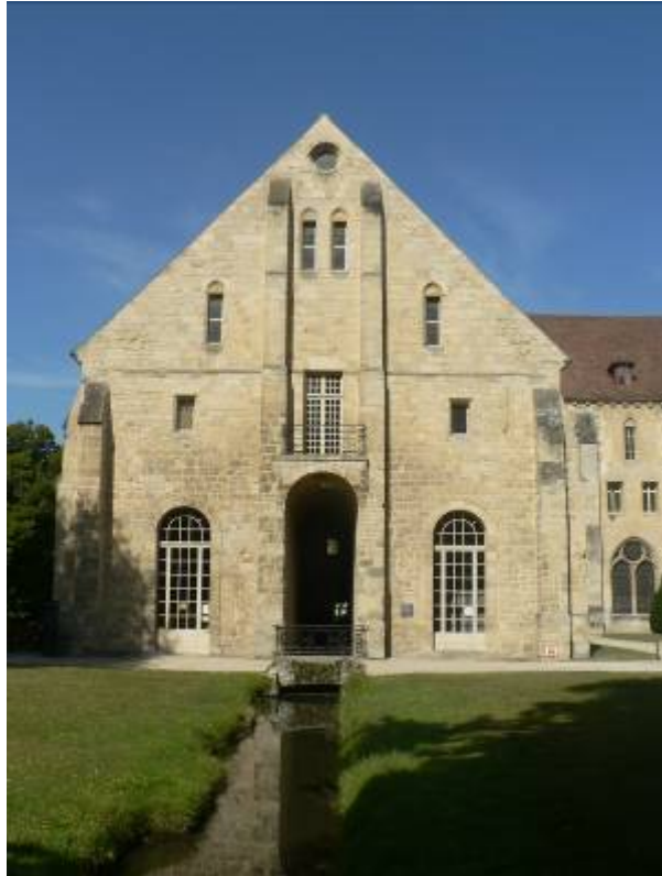
II. 181. Letrinas de la abadía de Royaumont, intersección de la panda claustral oriental con la meridional
