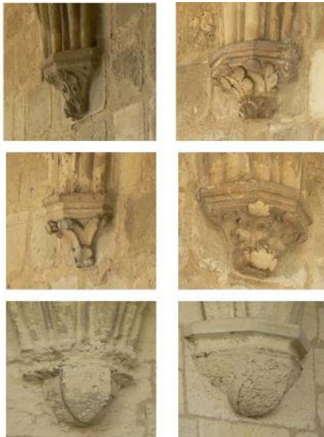
II. 140. Claustro de la abadía de Royaumont. Detalle de las ménsulas
