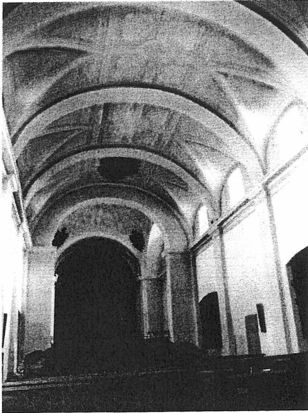
1. Sta. Mª de Carbajal. Interior de la iglesia
