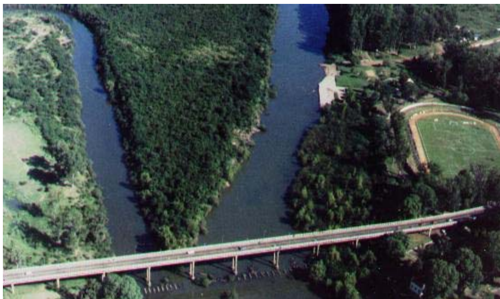
Foto 6.4.- Puente Internacional Concordia – Quaraí.
