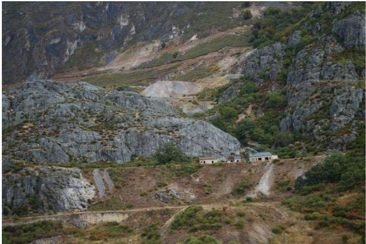
Aspecto actual de las Minas de San Andrés. Se observan las antiguas instalaciones y escombreras, que se encuentran parcialmente colonizadas por vegetación.
