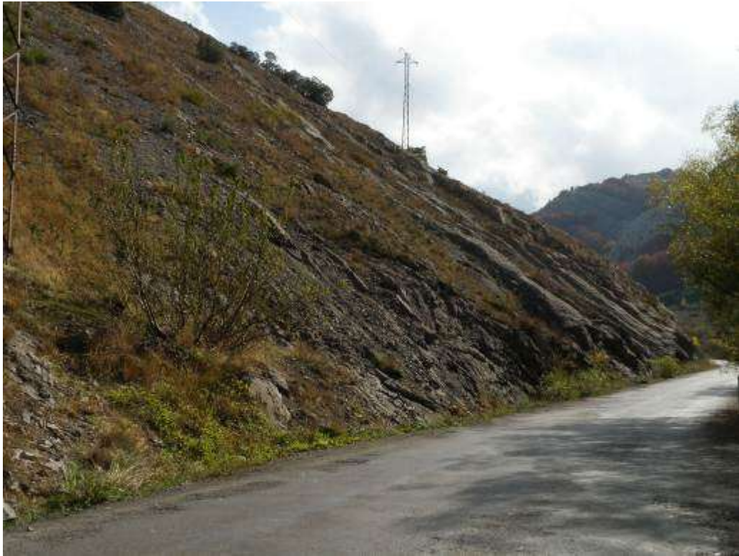
Fotografía 24144-PAL-003-1: Vista de la parte alta del Miembro II, constituido por calizas bien estratificadas con desarrollo de capas ricas en organismos bioconstructores
