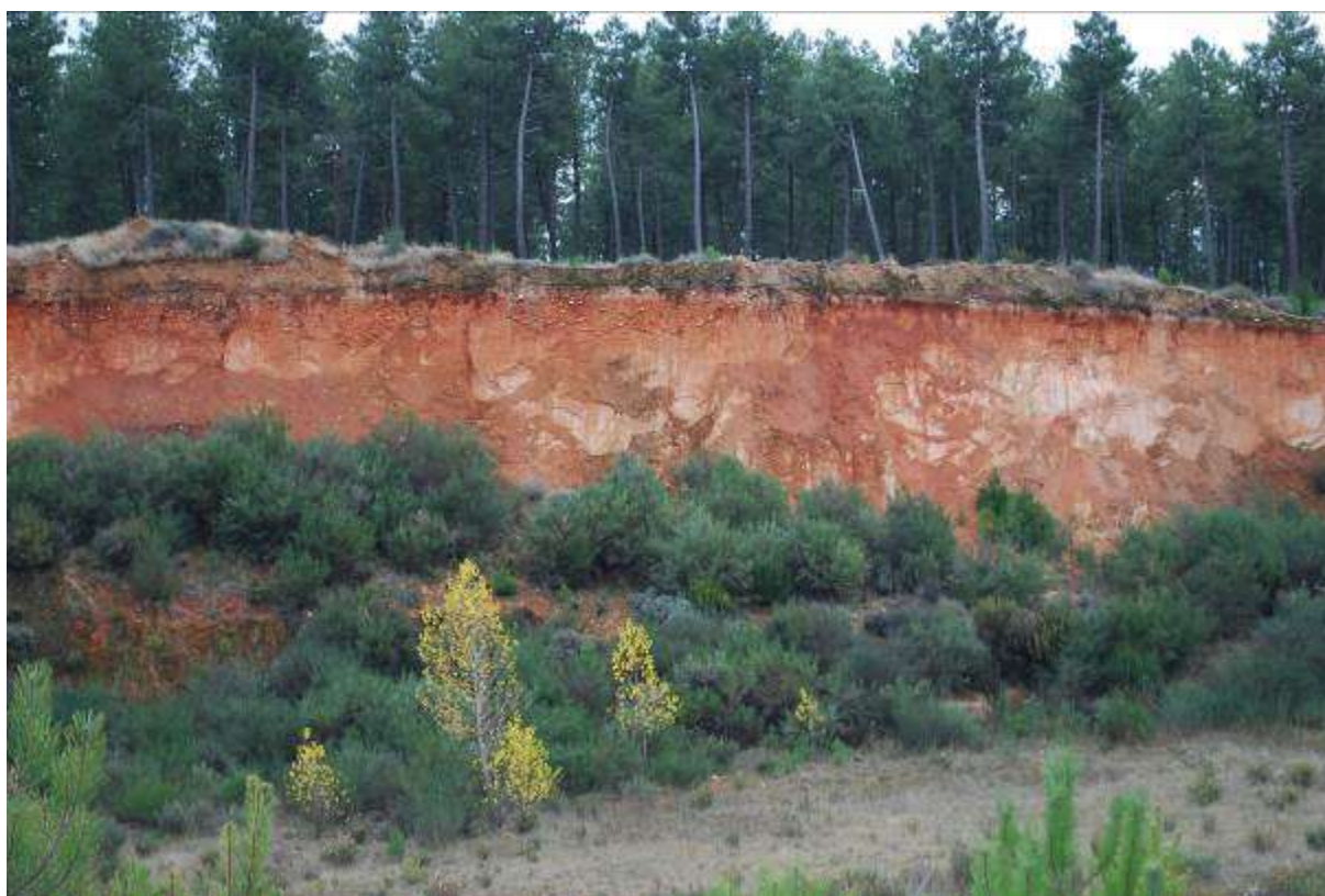
Talud de en el entorno de la antigua nacional IV a su paso por Montearenas. En él se observan unos 15 m de potencia de granito alterado o saprolita, que aparece rubefactada.
