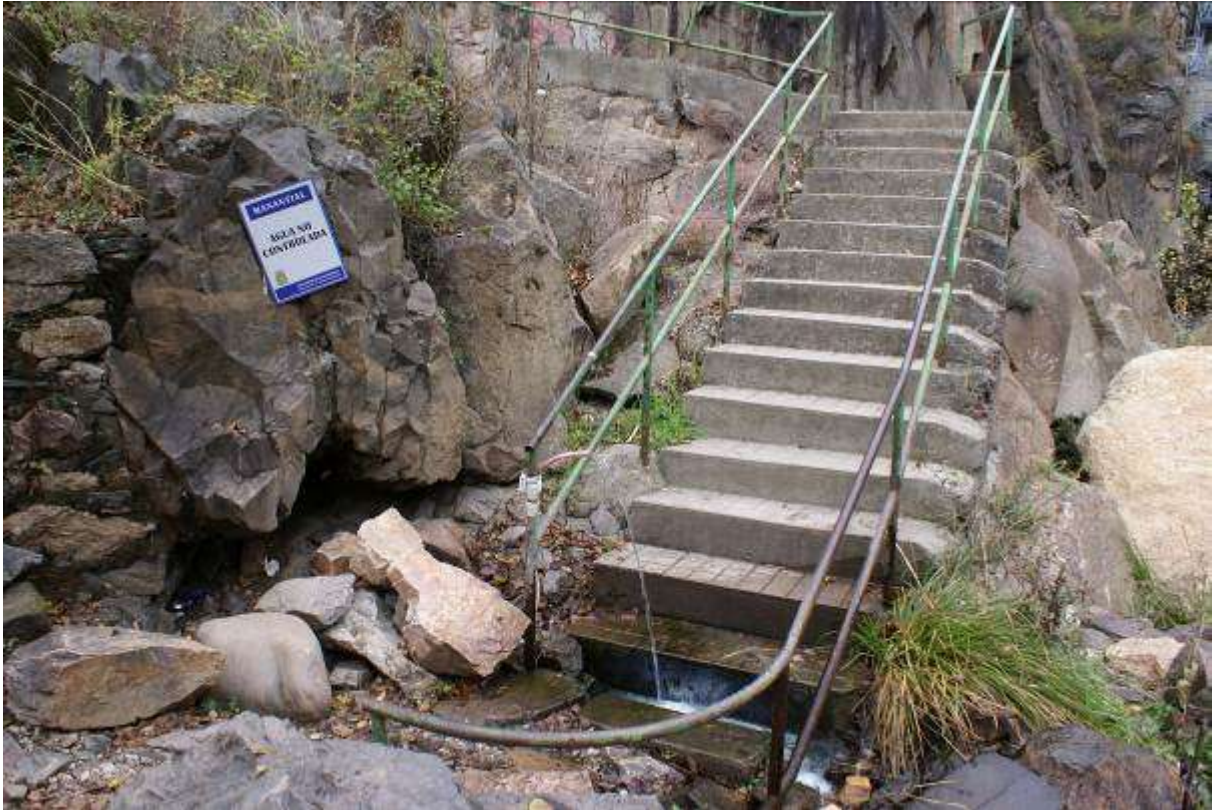
Fotografía 24115-HID-006-1: Aspecto actual de la Fuente del Azufre. Se aprecia la precariedad y pésimo acondicionamiento de las instalaciones (escalera, cartel y muy especialmente caño y goma de salida del agua).
