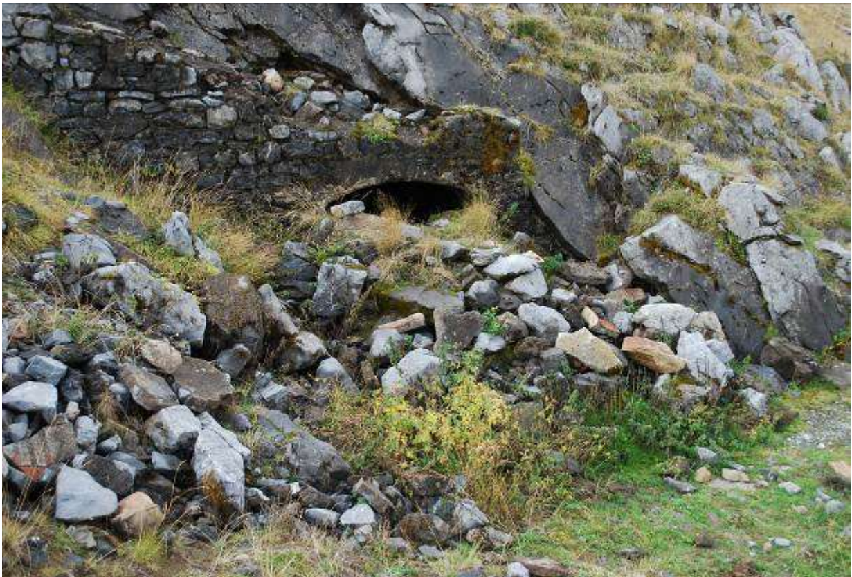
Situación actual de una de las entradas a la Mina "Escarlatti", la ubicada más abajo.
