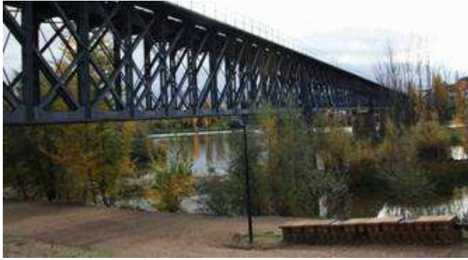
Figura 2.6 Puente sobre el Duero, PK 227, de seis tramos metálicos. Fuente : El Correo de Zamora
