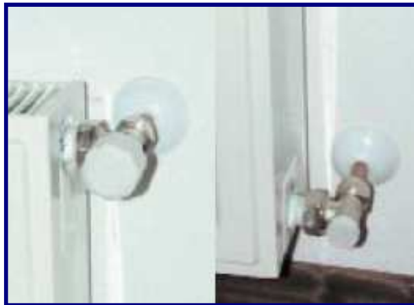
Figura 3.11: Radiador con conexión bitubo con llave de corte (superior) y detentor de reglaje (inferior) ( www.idae.es )
