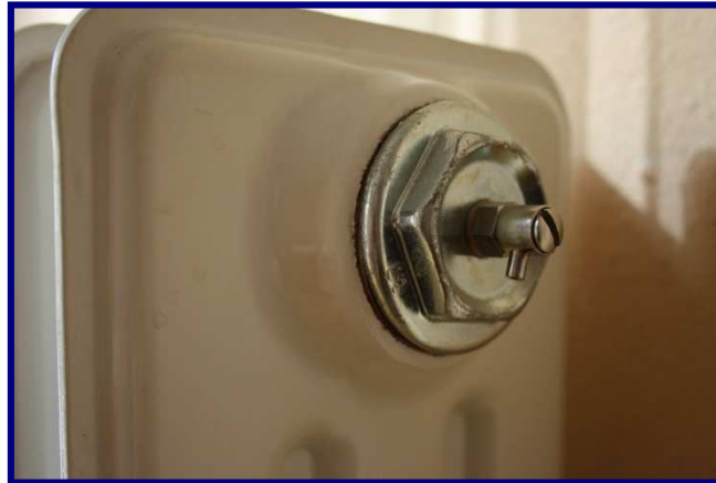
Figura 8.20: Purgador manual ( www.kw-solar.es )
