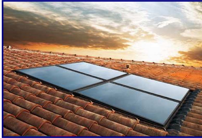
Figura 8.5: Ejemplo de una instalación solar con integración arquitectónica
