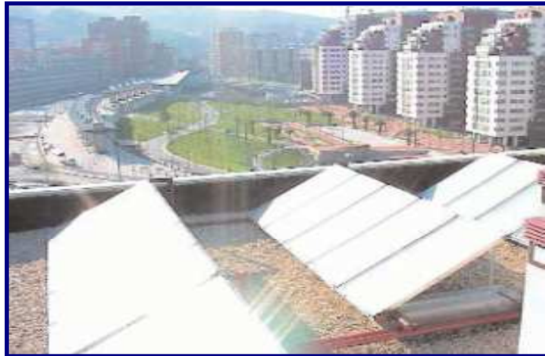
Figura 3.5: Colectores solares para instalaciones de calefacción y ACS ( www.idae.es )
