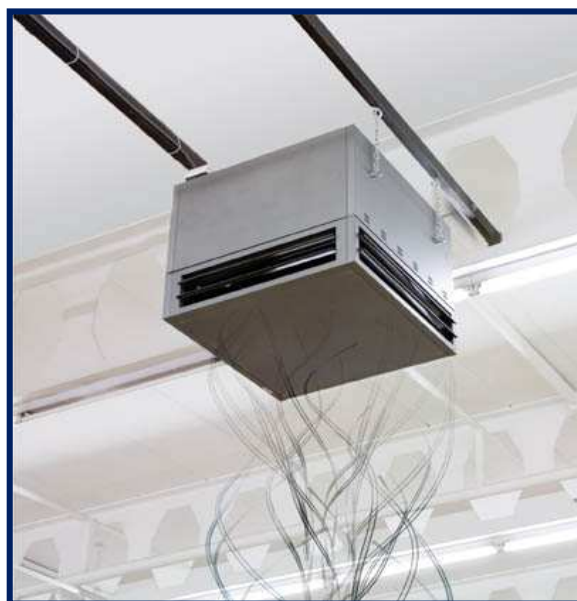
Figura 3.8: Instalación de calefacción mediante aerotermos ( www.jaga.info )
