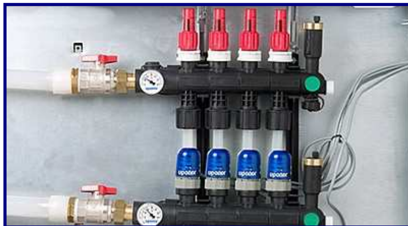
Figura 5.22: Colectores modulantes ( www.uponor.es )
