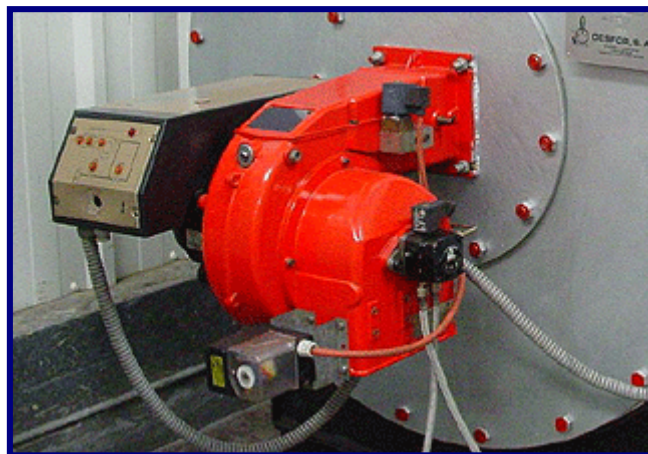
Figura 3.26: Quemador de combustible ( www.desforsa.com )
