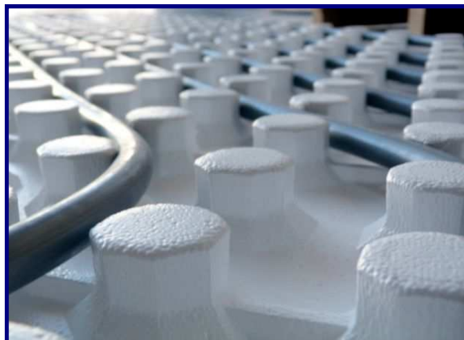
Figura 5.16: Montaje de tubos con paneles rígidos moldeados ( Grau )
