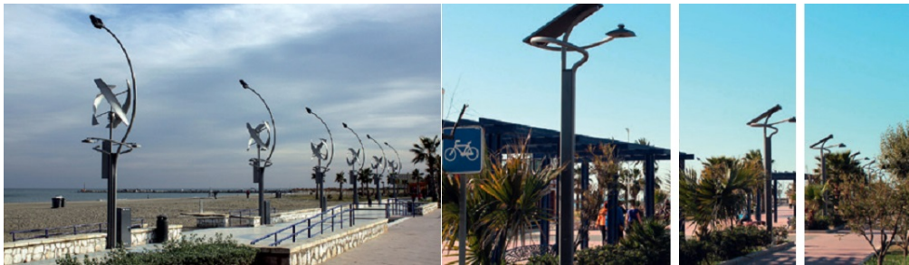
Figura 3-10: Sistemas de micro-generación en farolas (eólica y fotovoltaica, respectivamente). Fuente: [30]
