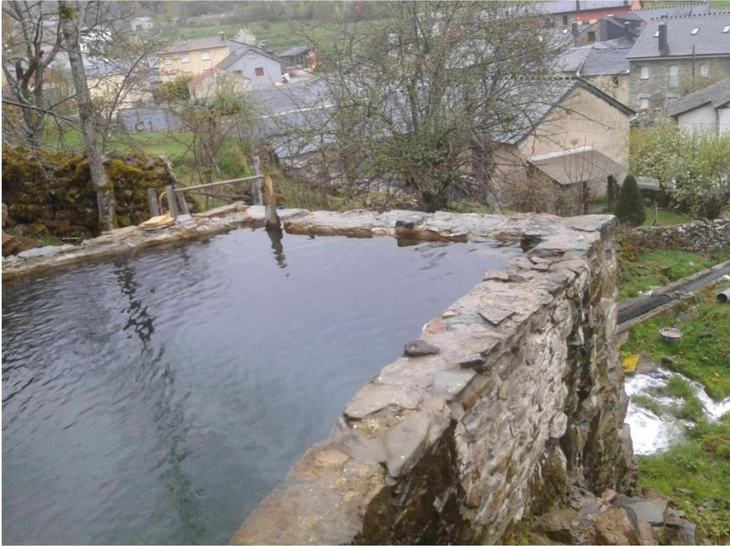
Figura 115.13 Cámara de carga
