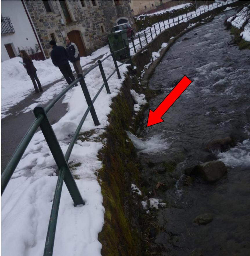
Figura 109.4 Zona de descarga de agua turbinada. Fachada N
