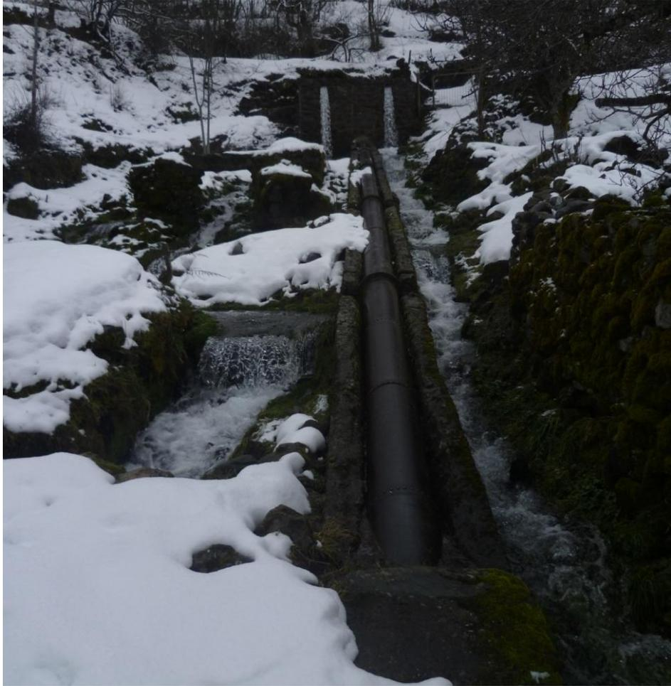
Figura 109.5 Cámara de carga, al fondo, y tubería forzada. Fachada S
