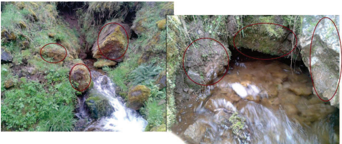
Figura 5-4 salida del agua y muestra del terreno presente, compuesto por tierra con grandes rocas procedentes de los derrubios.
