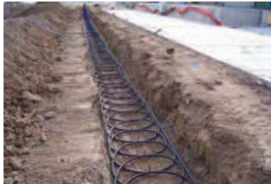
Figura 8.10.-Intercambiador horizontal en bucles de slinky horizontal.
