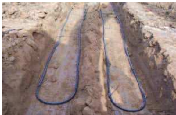
Figura 8.9.- Intercambiador horizontal de lazo simple.
