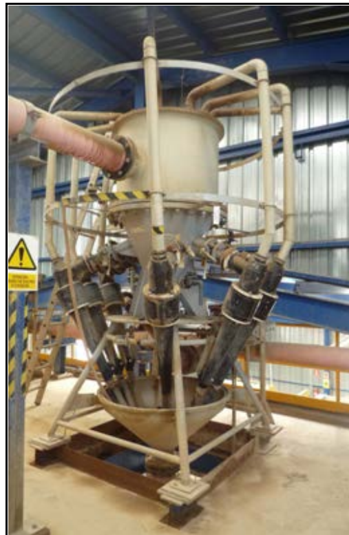
Figura 5.38. Hidrociclón de Yeso.
