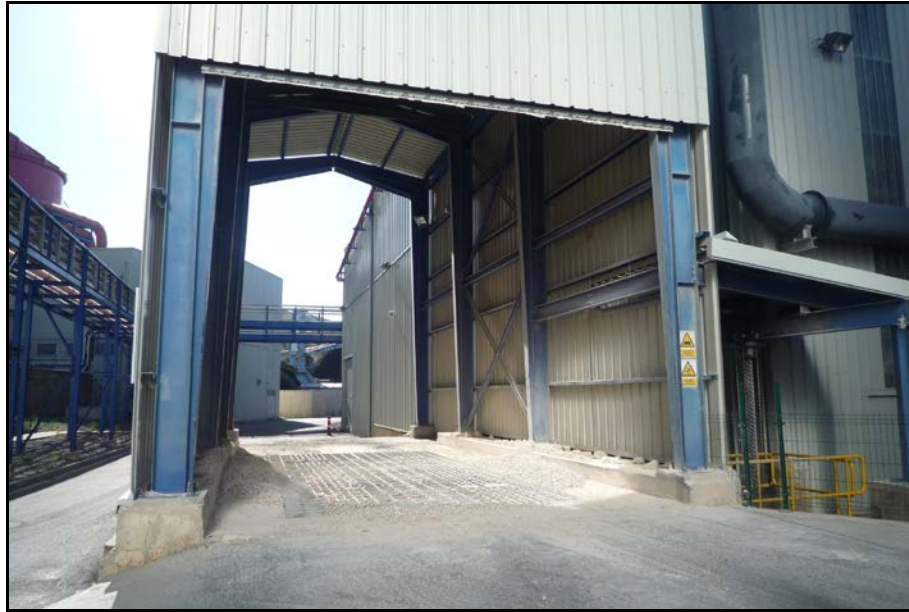
Figura 5.3. Cobertizo para la descarga de camiones de caliza.
