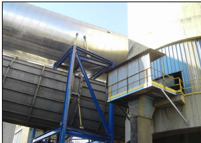
Figura 5.22. Detalle del montaje de los conductos de gases de combustión.
