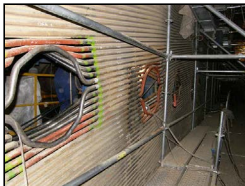
Figura 7.21. Reforma en los tubos de la caldera.
