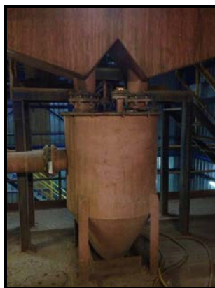
Figura 5.34. Tanque de Distribución.
