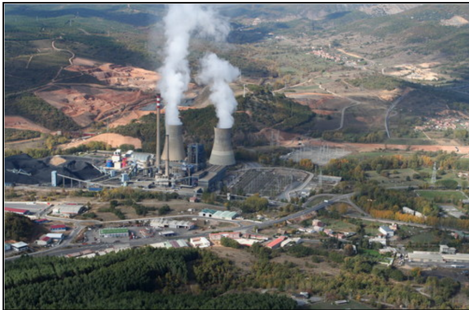
Figura 1.1. Central térmica de carbón.
