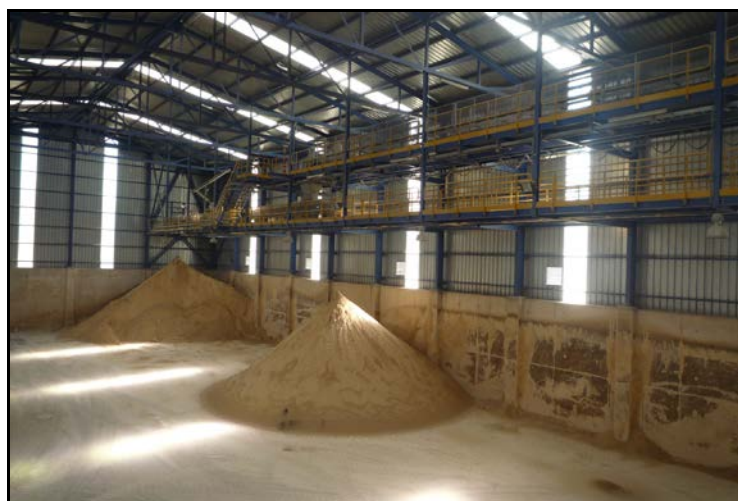
Figura 5.44. Edificio de Almacenamiento de Yeso.
