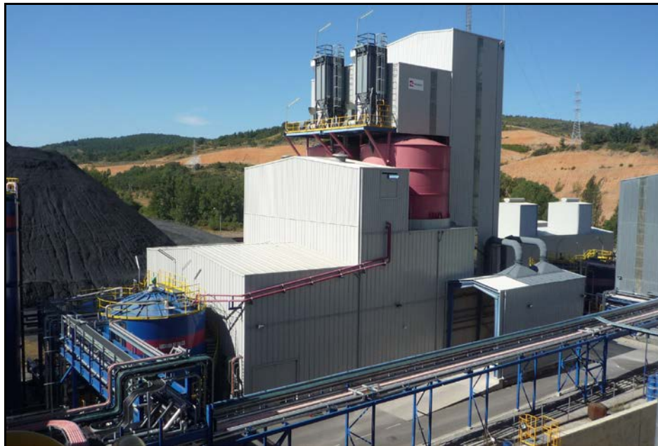
Figura 5.64. Sistemas de Caliza, Molienda y Alimentación de Lechada de Caliza.
