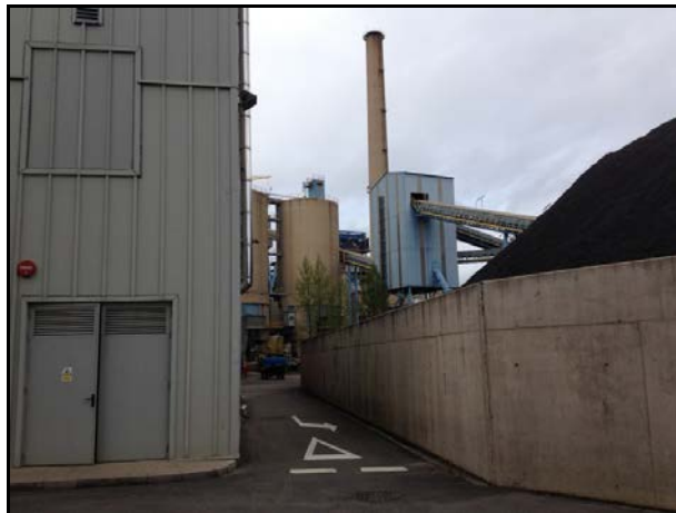
Figura 5.67. Zona de obras para la ampliación de la nave de Bombas de Recirculación.
