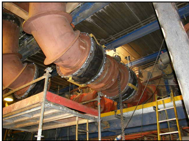
Figura 7.22. Conductos de aire OFA.
