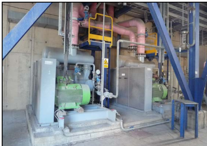
Figura 5.40. Bombas de Vacío.
