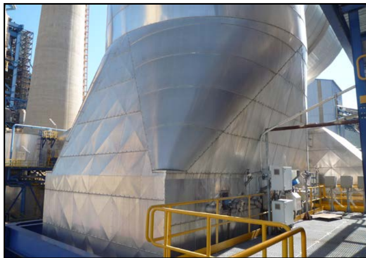
Figura 5.19. Calentador Gas - Gas (GGH).
