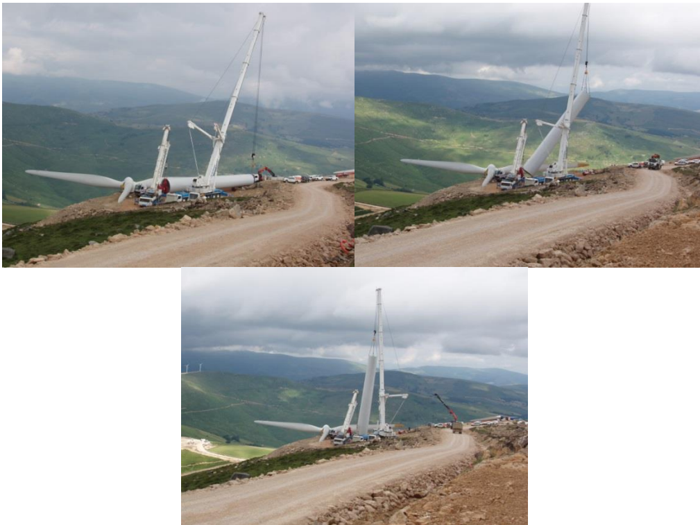
Figura 3.2 Montaje del Aerogenerador
