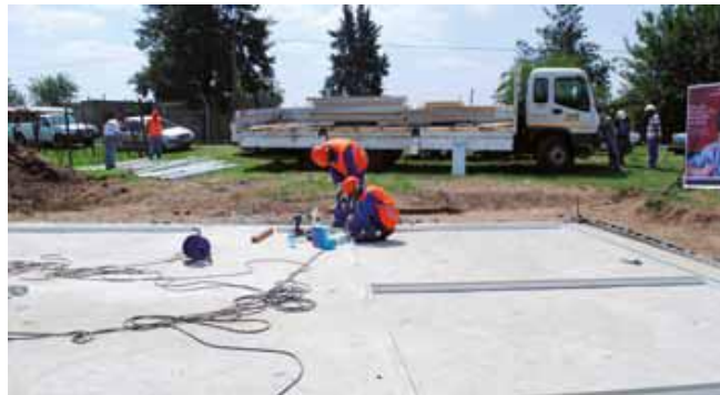
Figura 5.22 Colocación de perfiles en U.
