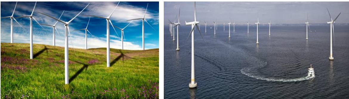
Figura 4.28 Parques eólicos terrestres y marinos.
