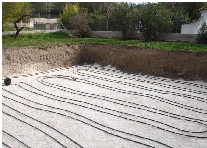
Figura 4.72 Red de captadores horizontales.
