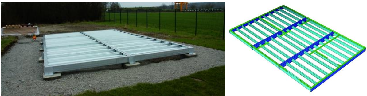
Figura 5.4 Estructura de acero.
