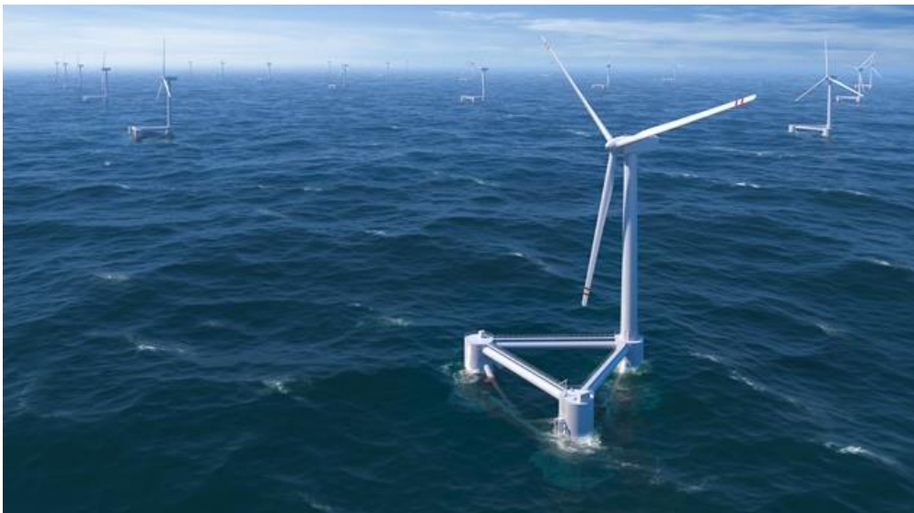
Figura 4.39 Aerogeneradores marinos con estructura flotante.
