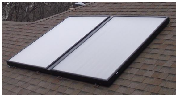
Figura 4.63 Captadores de placa plana.
