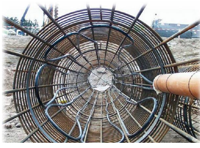
Figura 4.77 Pilote con colocación de conductores.
