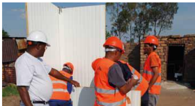
Figura 5.23 Colocación de los dos primeros paneles.
