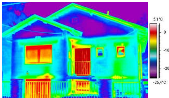
Figura 3.7 Imagen termográfica de los puentes térmicos de una vivienda.
