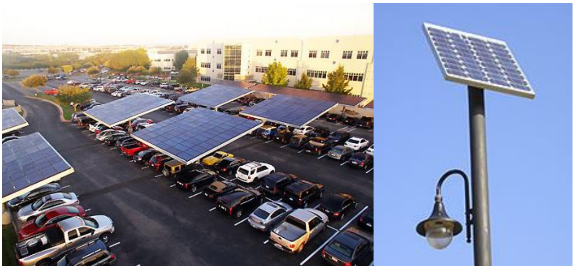
Figura 4.56 Cubiertas fotovoltaicas en parking y farolas alimentadas con energía fotovoltaica.
