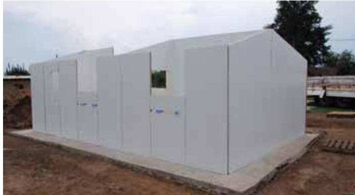
Figura 5.24 Colocación de los dos últimos paneles.
