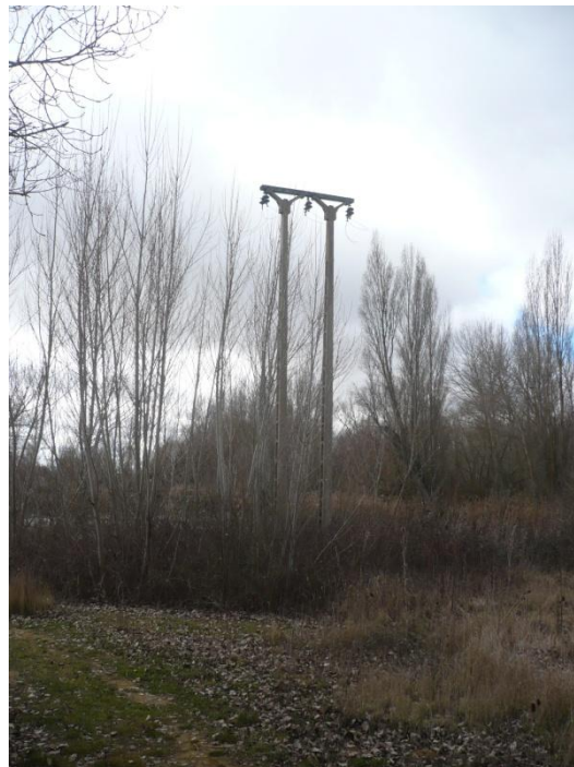
Figura 8.11. Palones que sujetarán los cables.
