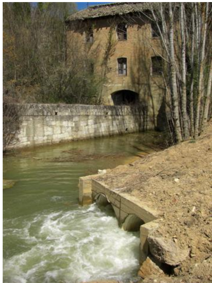
Figura 110.6.-Canal de desagüe.
