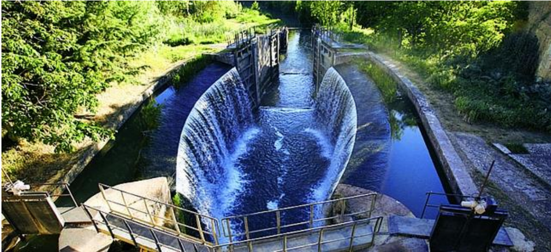
Figura 5.1.- Imagen de las esclusas, en la que se aprecia el desnivel.
