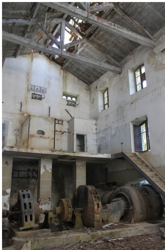
Figura 110.10.- Estado actual del interior del edificio.
