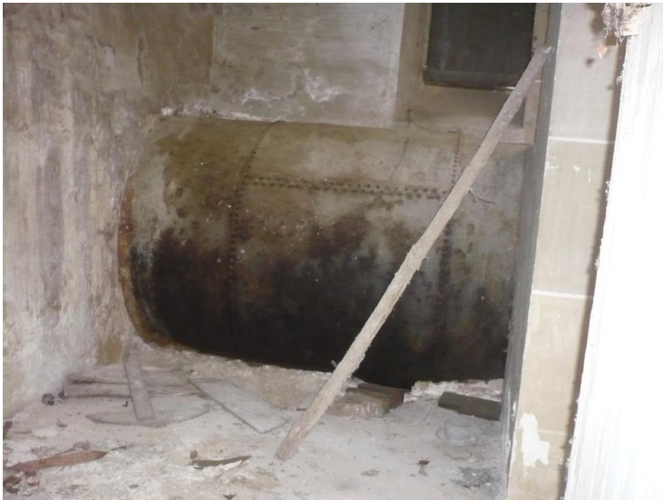
Figura 7.2.- Tubería a la entrada de la antigua turbina.
