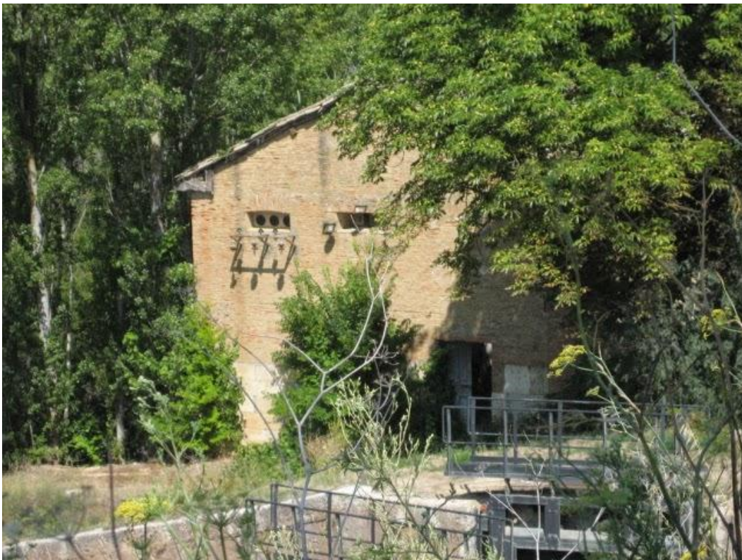
Figura 110.2.-Edificio de la central.
