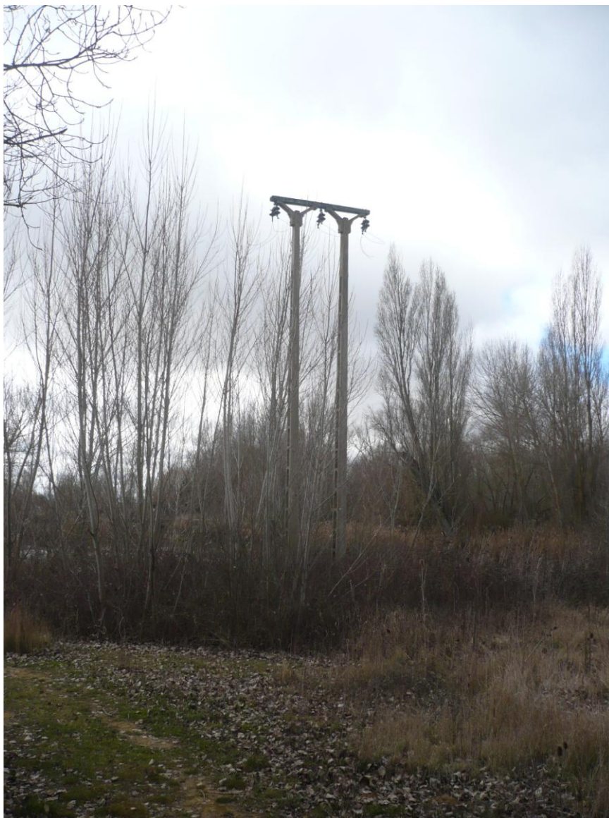
Figura 110.13.-Palones de la línea eléctrica.
