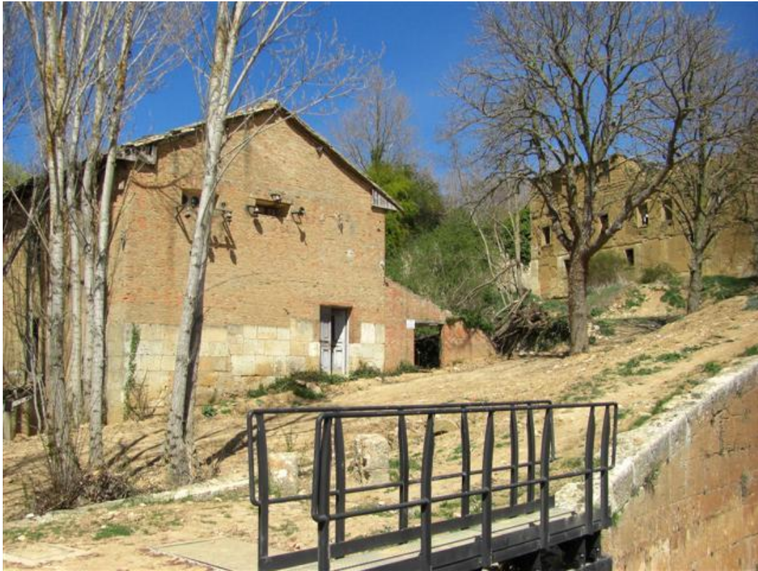
Figura 110.3.-Casa de máquinas y antiguo molino.
