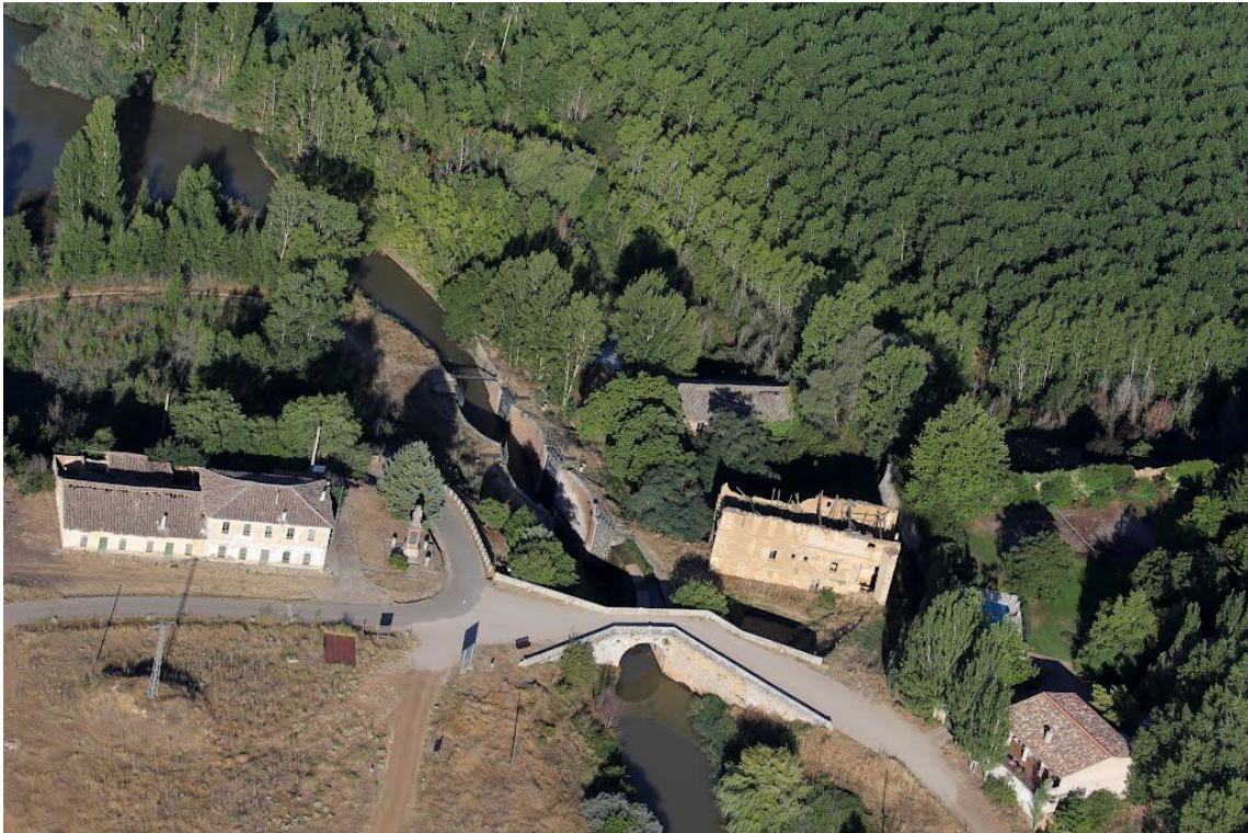
Figura 110.1.- Vista aérea del Canal de Castilla.
