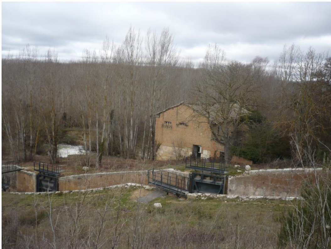
Figura 110.4.-Edificio de la central visto desde la carretera.
