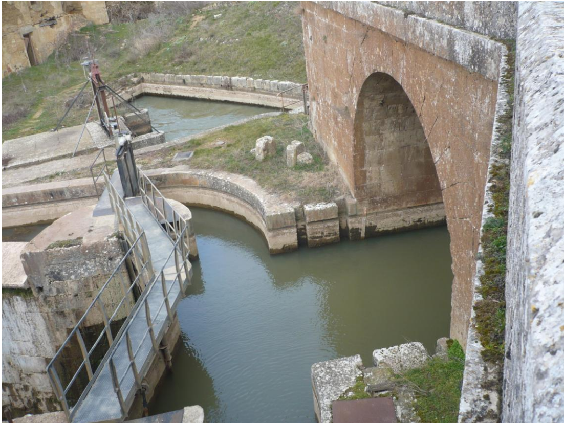
Figura 110.7.-1ª esclusa con las compuertas cerradas.
