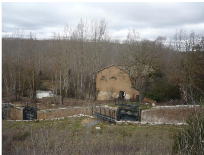
Figura 7.3.- Edificio de la central.
