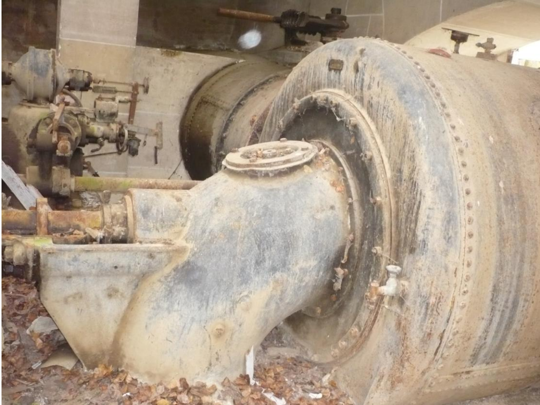
Figura 110.9.-Tubería y antigua turbina.
