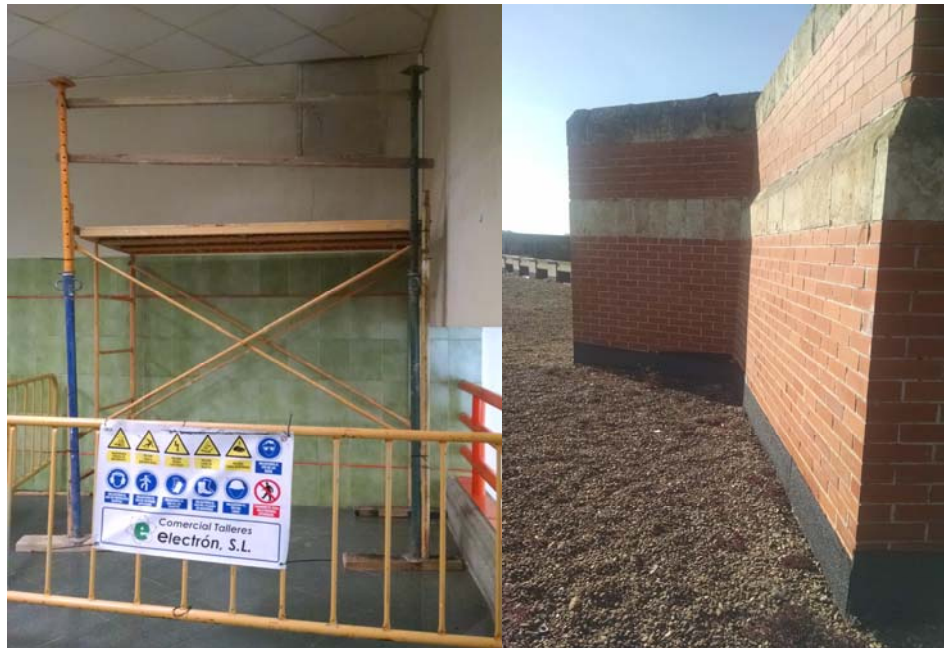
Figura 8.3 Acceso actual a la cubierta y lugar propuesto para la escalera exterior
