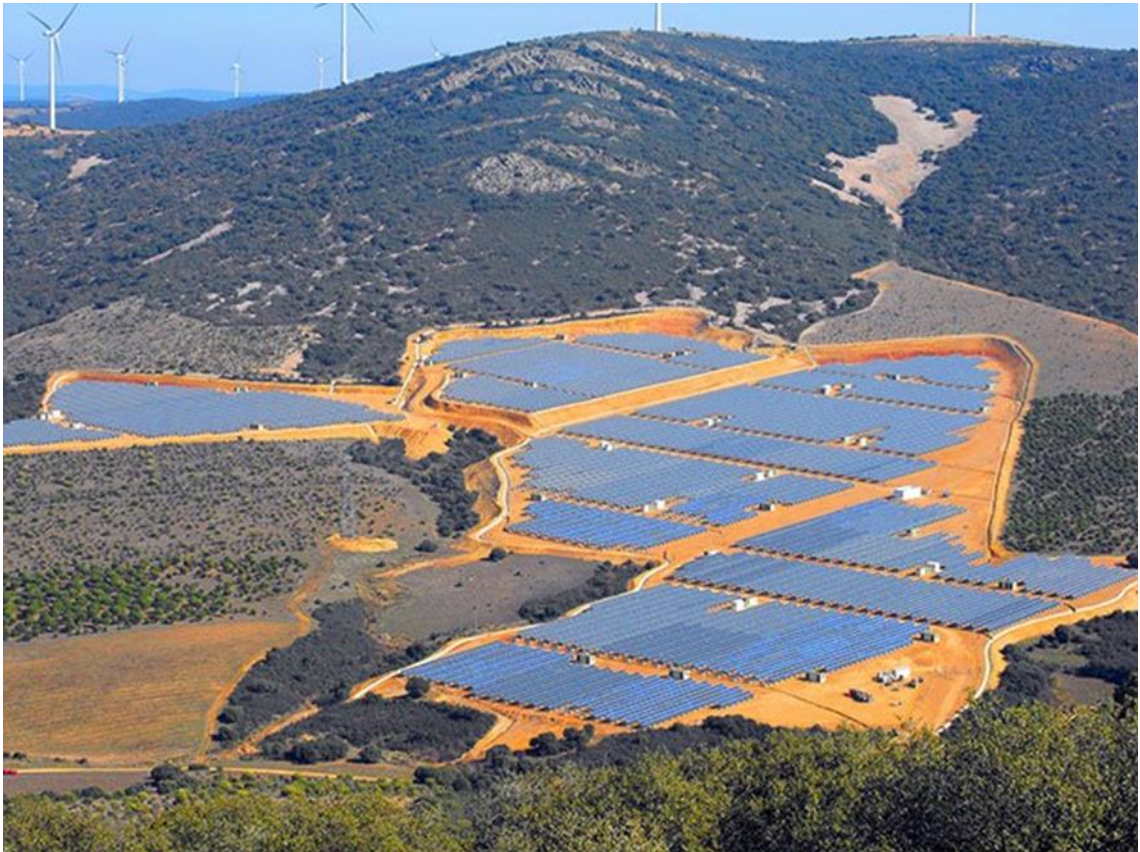
Figura 1.6.- Campo solar fotovoltaico.
