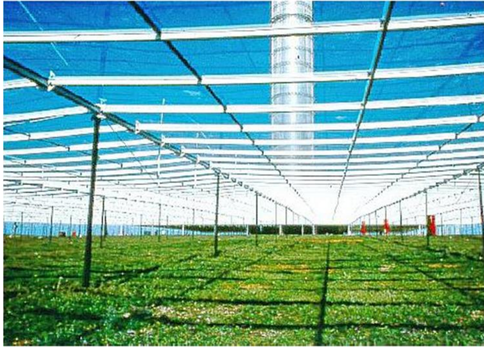
Figura 3.9.- Estructura portante del vidrio del colector.
