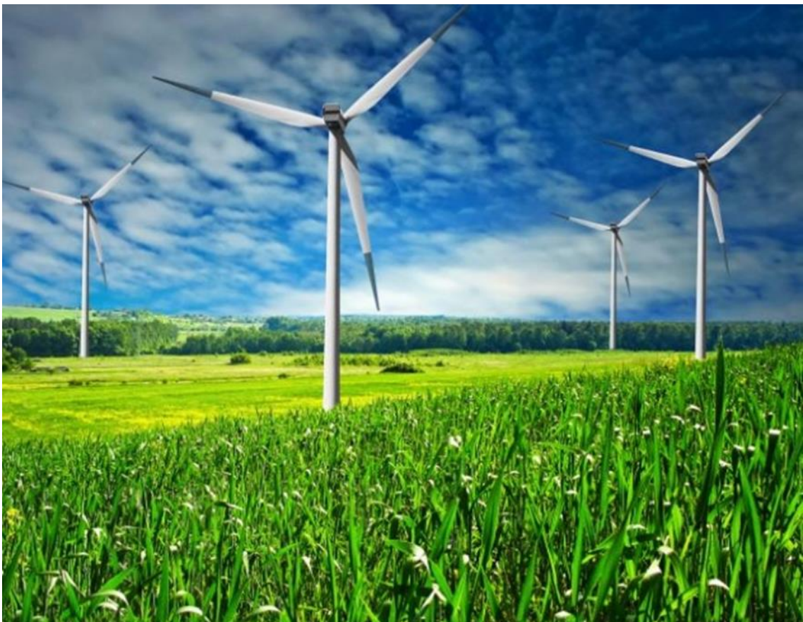
Figura 1.3.- Aerogeneradores de un parque eólico.
