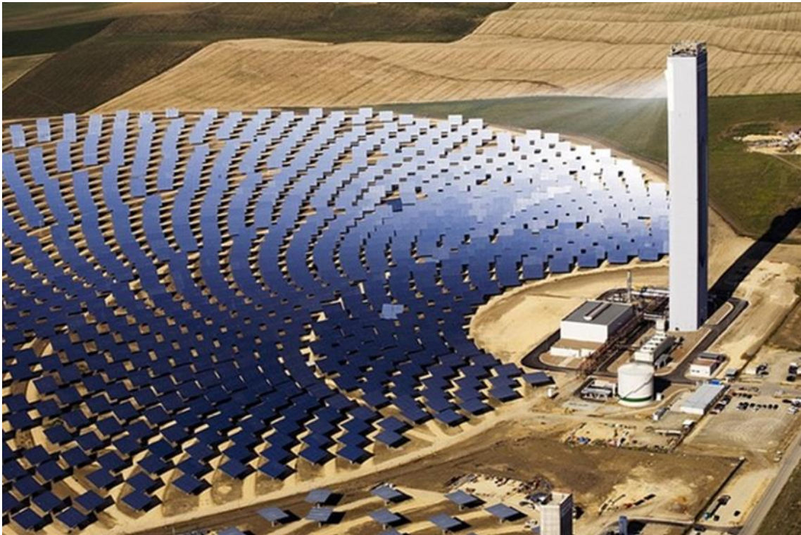
Figura 1.8.- Planta de energía solar térmica concentrada.
