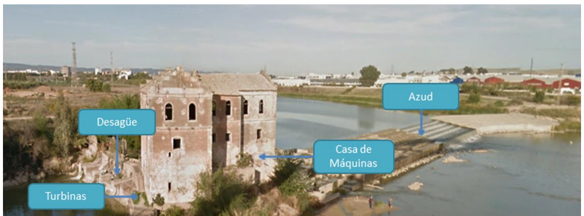
Figura 10.1 Esquema de la central hidroeléctrica
