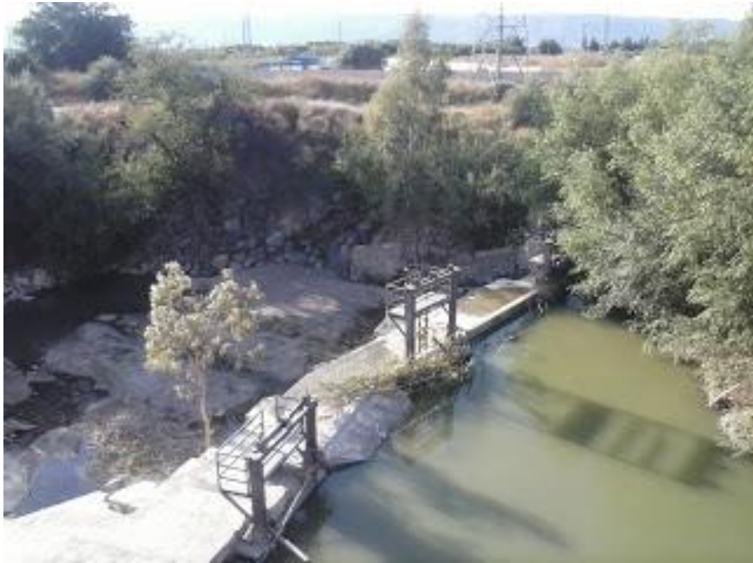
Figura 0.25 Aliviaderos y desagüe vistos desde tercer piso
