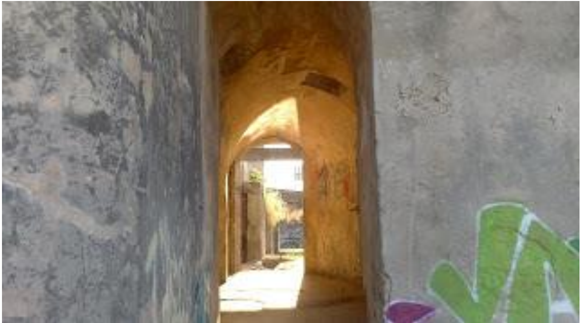
Figura 0.19 Parte lateral interior del molino
