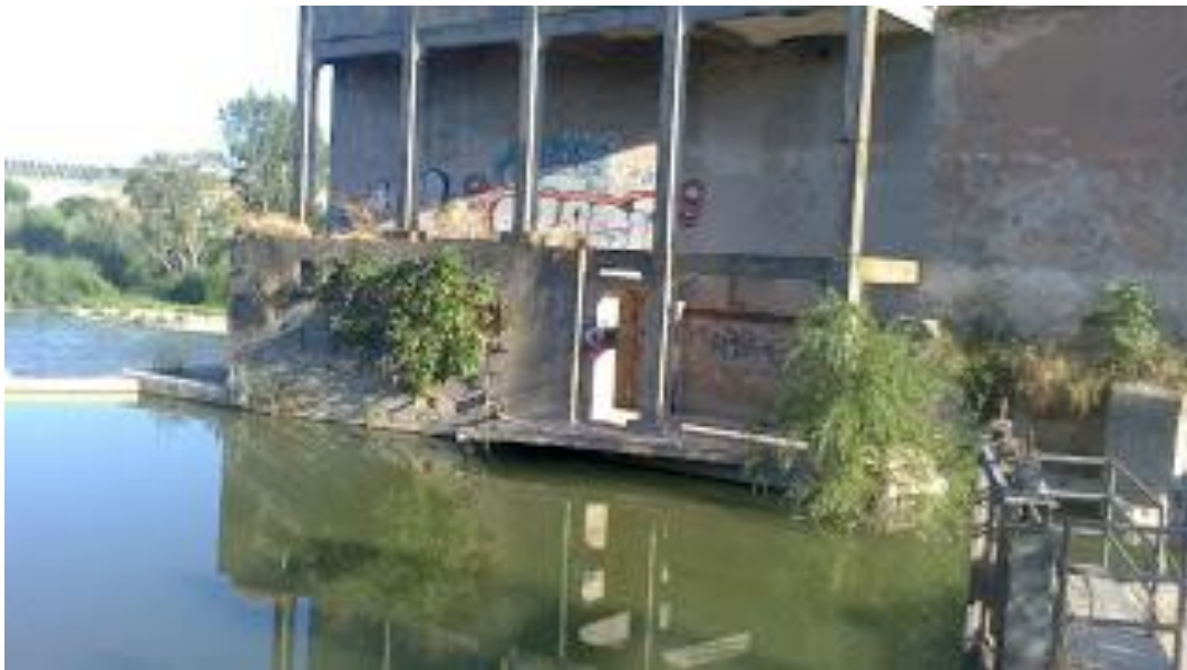
Figura 0.9 Cámara de carga
