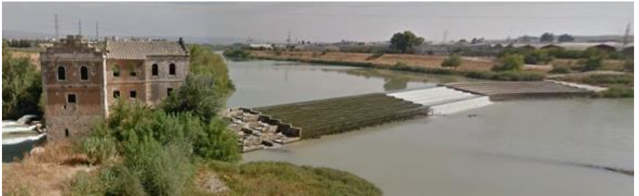
Figura 0.27 Azud y molino desde puente Abbás Ibn Firnás
