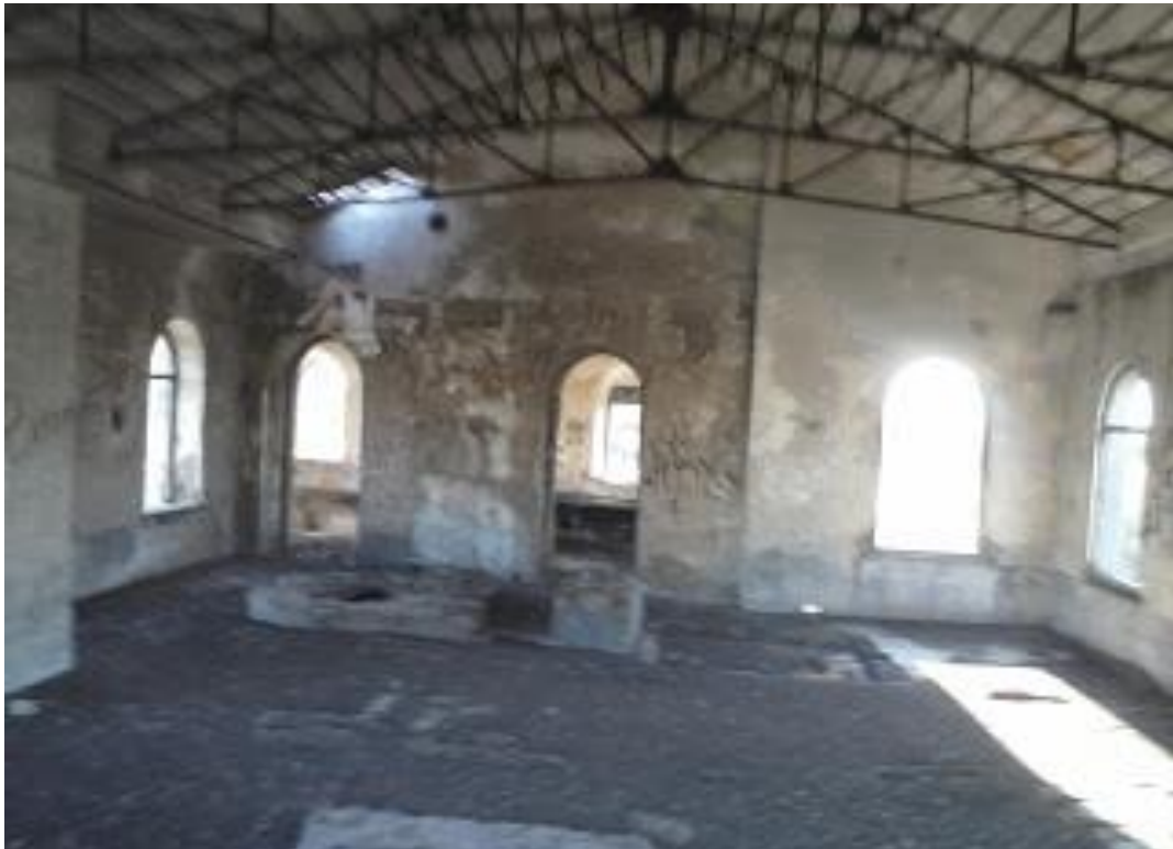
Figura 0.21 Interior del tercer piso
