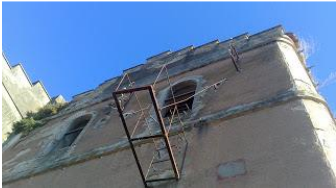
Figura 0.12 Fachada de acceso cerrada
