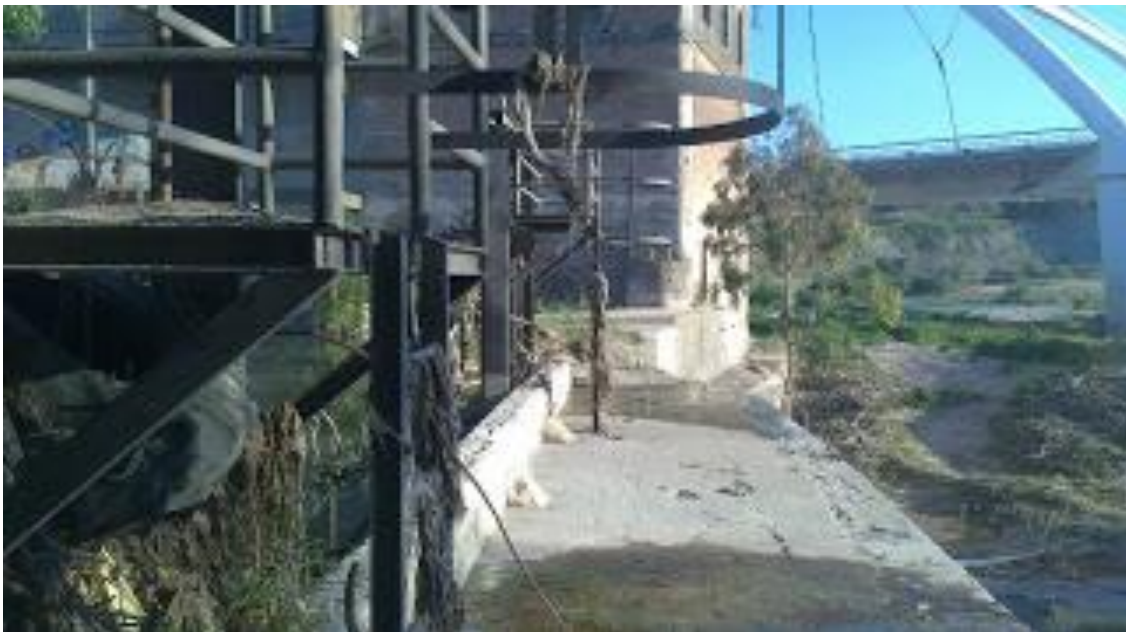
Figura 0.8 Aliviaderos y desagüe del molino
