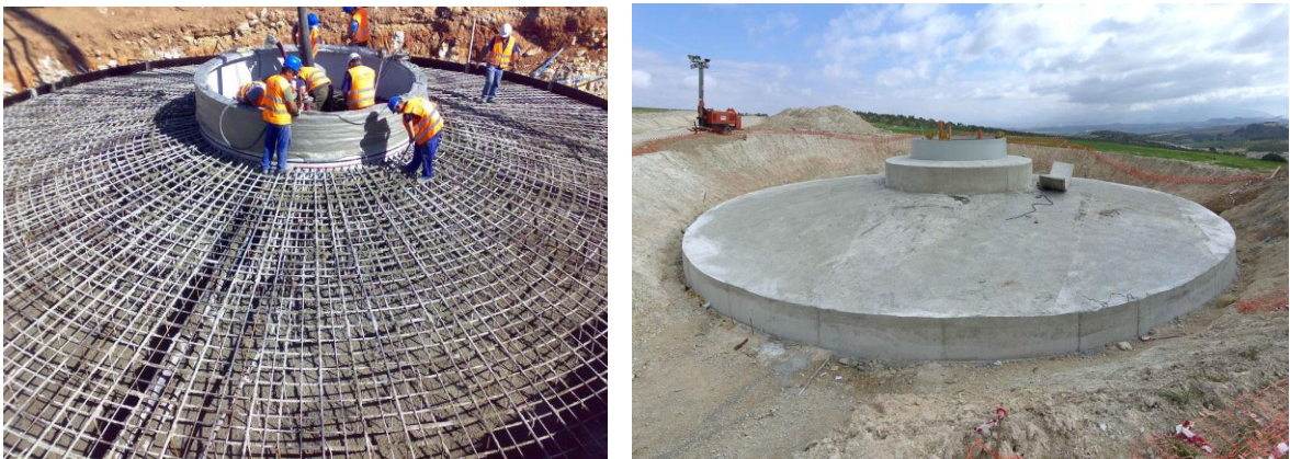
Figura 6.3. Cimentación aerogenerador
