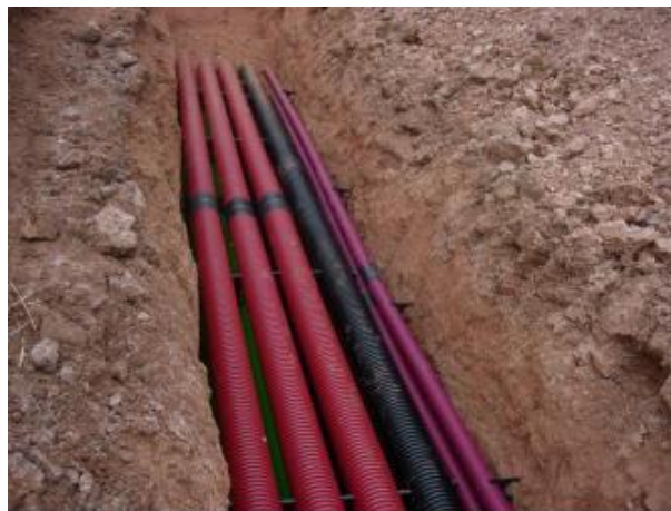
Figura 6.4. Canalización red de media tensión
