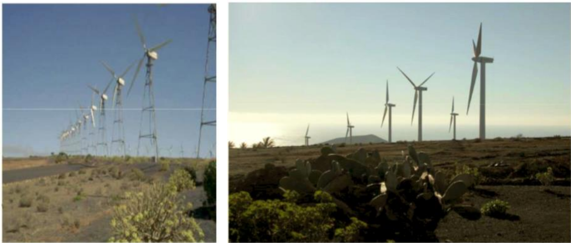
Figura 3.1. Parque eólico Los Valles antes y después
