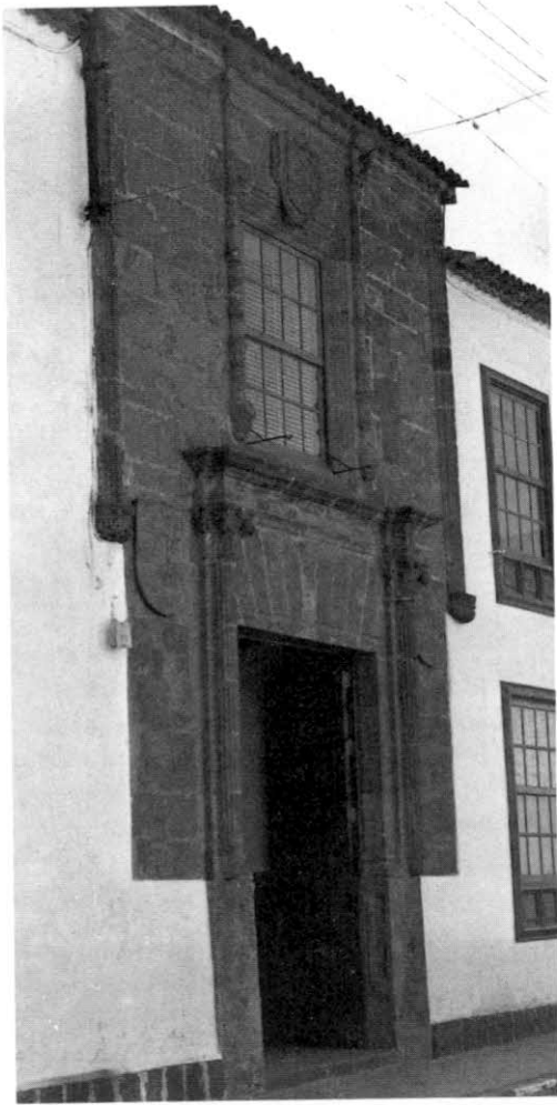
Lámina 3. Casa del Corregidor, San Cristóbal de La Laguna.
