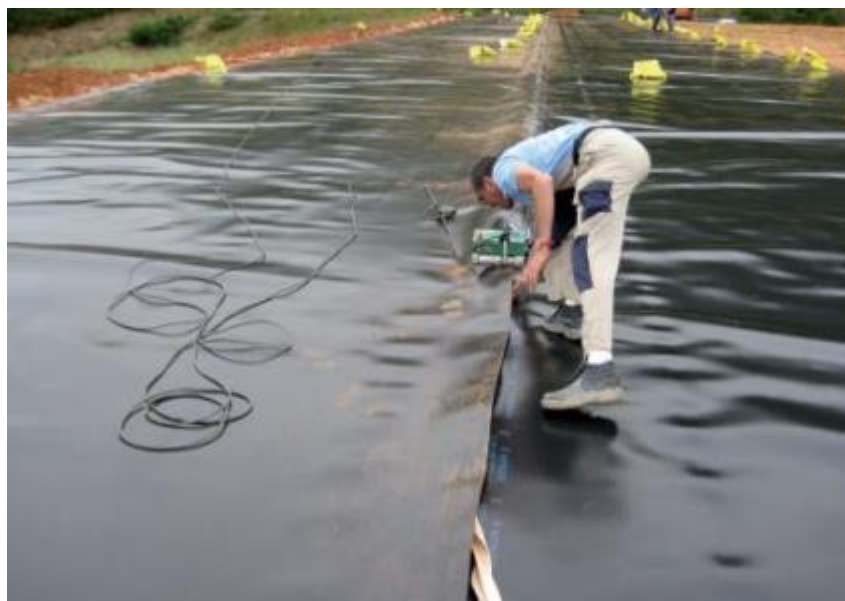
Figura 16.1.- Proceso de sellado de balsas.
