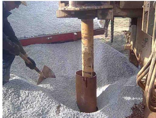
Figura 7.8. Proceso de engravillado.
