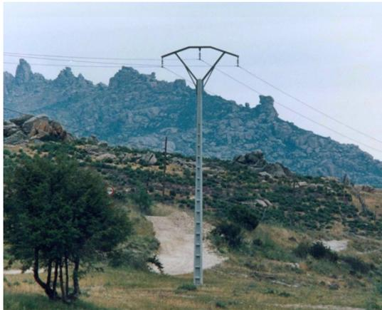
Figura 4.9.2. Apoyo de hormigón HV
