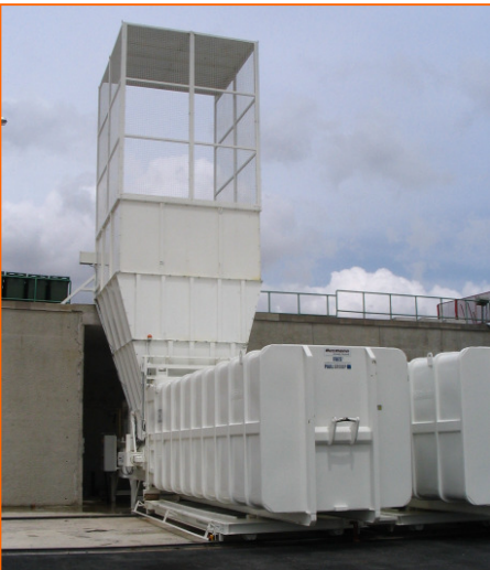
Estación de transferencia con tolva para descarga directa desde camión
