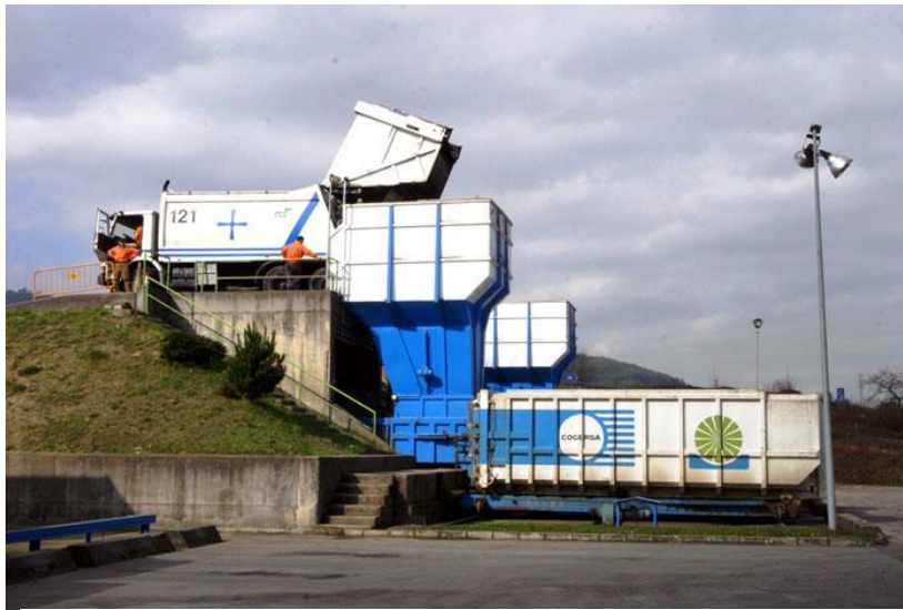
Figura 2-1.- Estación de transferencia en Belmonte.
