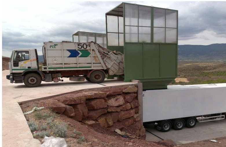
Figura 2-2.- Camión descargando en una Estación.
