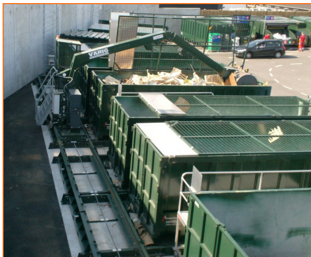
Rodillo compactador deslizante
