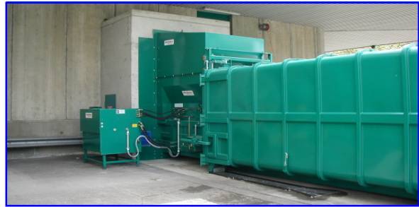
MP con tolva conectada a la pared
