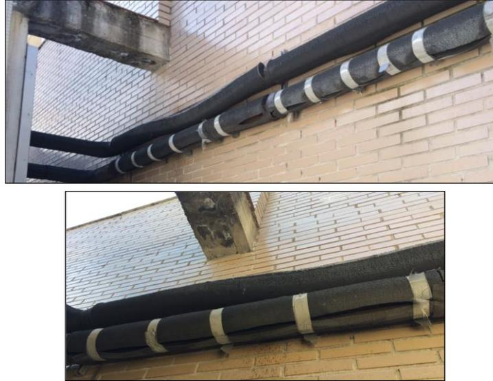
Ilustración 6.5. Aislamiento de las tuberías de conexión
