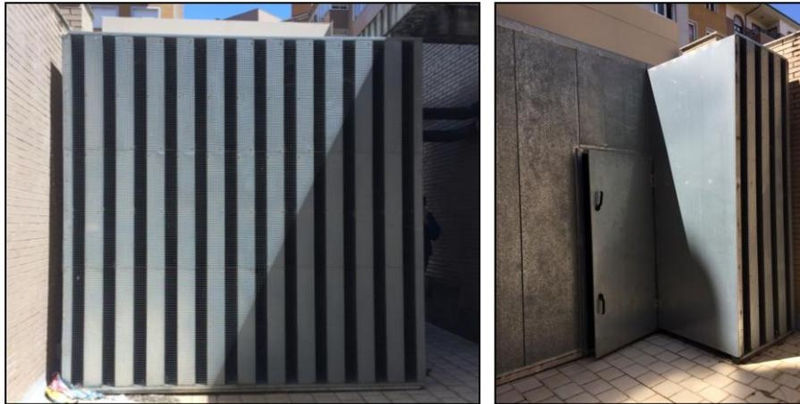
Ilustración 7.8. Cápsula de aislamiento acústico del Supermercado
