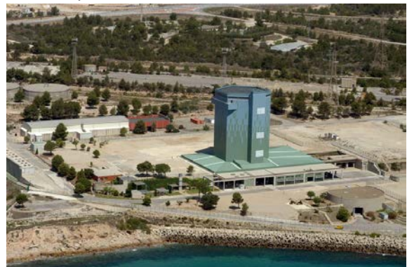
Ilustración 6-3 Reactor encapsulado Vandellós I
