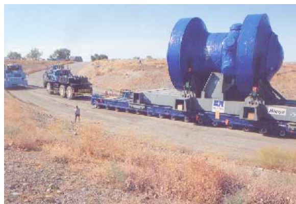
Ilustración 6-2 Extracción de la Vasija de Reactor de la Central Nuclear Trojan
