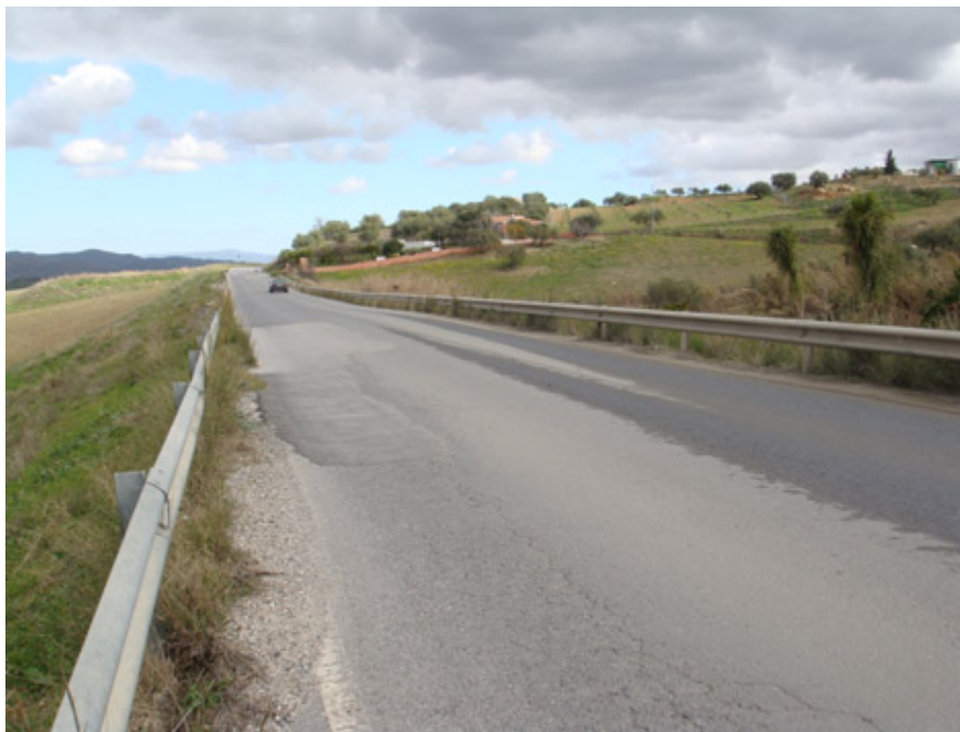
Fig. 1.15. Ejemplo de blandón en una carretera (Teleprensa, 2010).
