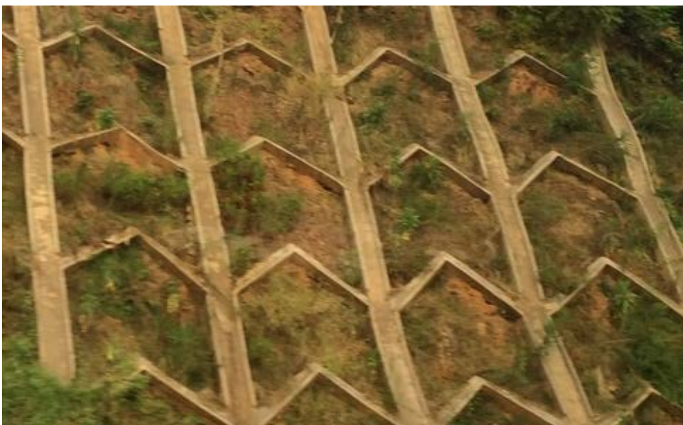
Fig. 3.5. Sistema de drenaje empleado en un talud de China para minimizar la erosión.
