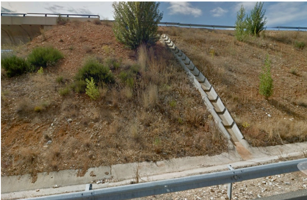
Fig. 3.3. Bajante en ramal de acceso a la ronda LE-30.
