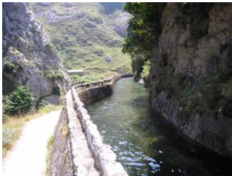
Fig. 1.3. Canal que recoge las aguas del desmonte en el Cares (León).
