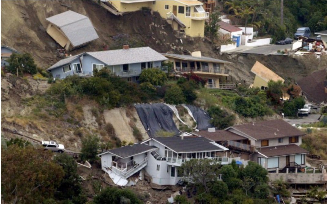
Fig. 1.20. Deslizamiento de terraplén provoca muertos en U.S.A (Usahispanicpress, 2014).
