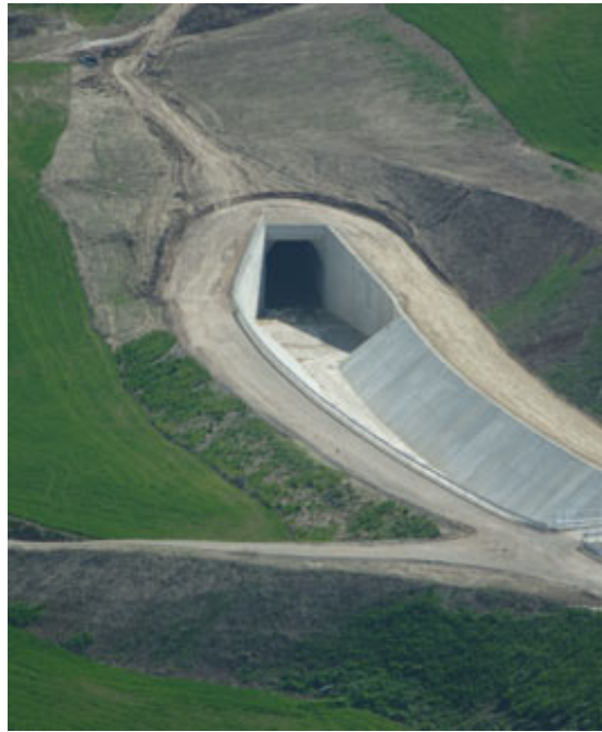
Fig. 1.2. Canal de grandes dimensiones que recoge las aguas del terraplén (COPISA, 2008).
