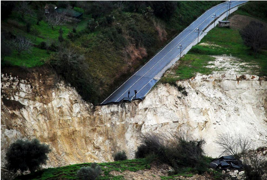
Fig. 1.18. Deslizamiento de ladera en Maierato, Italia (Montalar, 2010).
