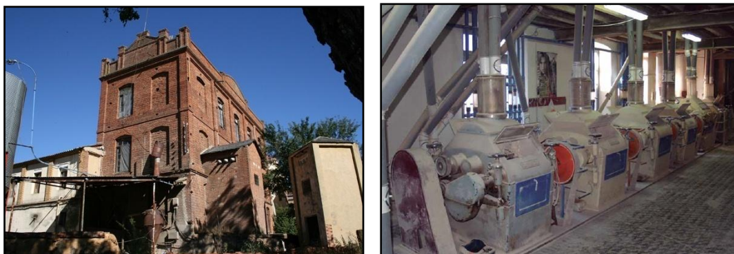
Figs. 128-129: Fábrica de harinas “La Cepedana”, exterior en 2007 e interior (planta de molinos). Fotografías: Javier Revilla Casado (izda.) y David Marcos González (dcha.).
