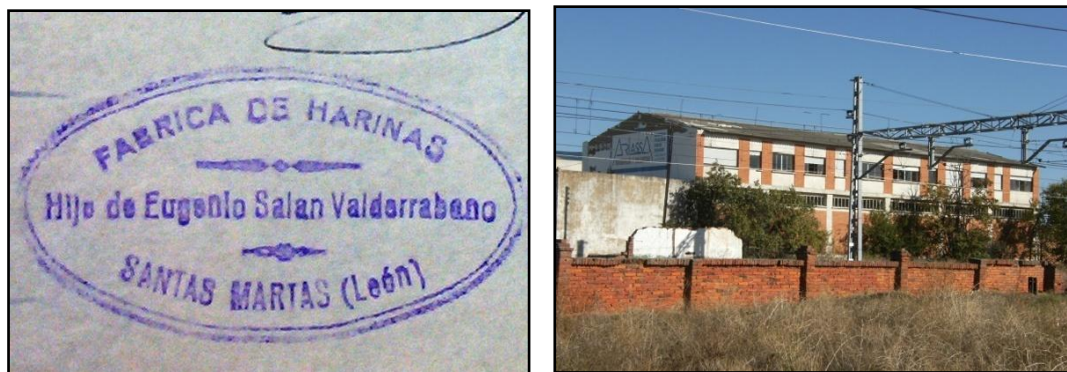
Figs.118-119: Fábrica de harinas “La Elena” de Valdearcos, sello de 1957 (izda.) y fotografía en su estado actual (dcha). Fotografías: AHPL (sello) e imagen tomada por Javier Revilla Casado (autor).
