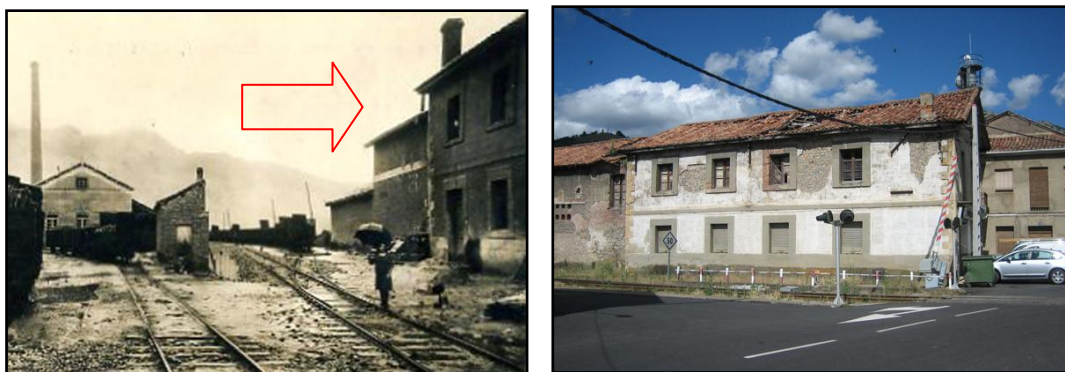
Figs. 96-97: Fábrica de harinas “La Moderna”, vista parcial antigua (izda) y fotografía en su estado actual (dcha). Fotografías: Autor desconocido (izda) e imagen tomada por Javier Revilla Casado (dcha).
