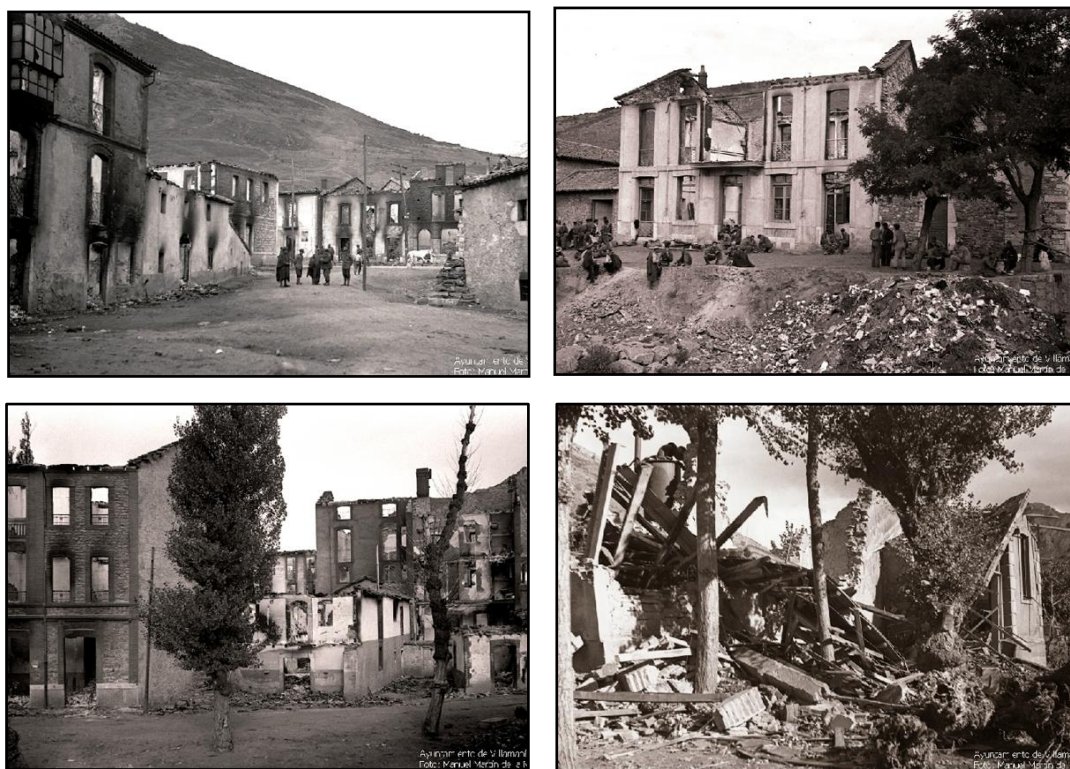
Figs. 1-4: Destrucción de Villamanín (León). Fotografías: Manuel Martín de la Madrid (Foto Exakta). http://www.ayuntamientovillamanin.com/galeria/
