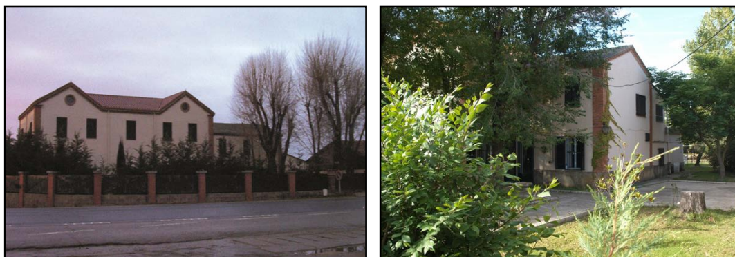
Figs. 130-131: Fábrica de harinas “La Concepción”, imágenes en su estado actual. Fotografías: Javier Revilla Casado (izda.) y David Marcos González (dcha.).
