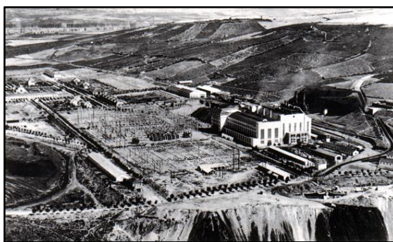
Fig. 19: Central Termoeléctrica de Compostilla I. Fotografía: ENDESA.
