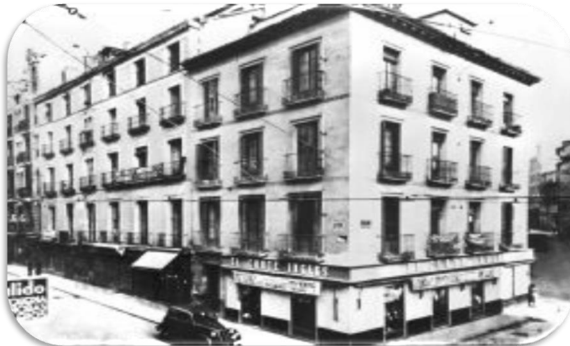
Figura 6.1. Fachada de El Corte Inglés de la Calle Preciados de Madrid
