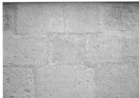
Figura 13. Zócalo del muro Norte de la nave por el exterior. Marcas de cantero.
