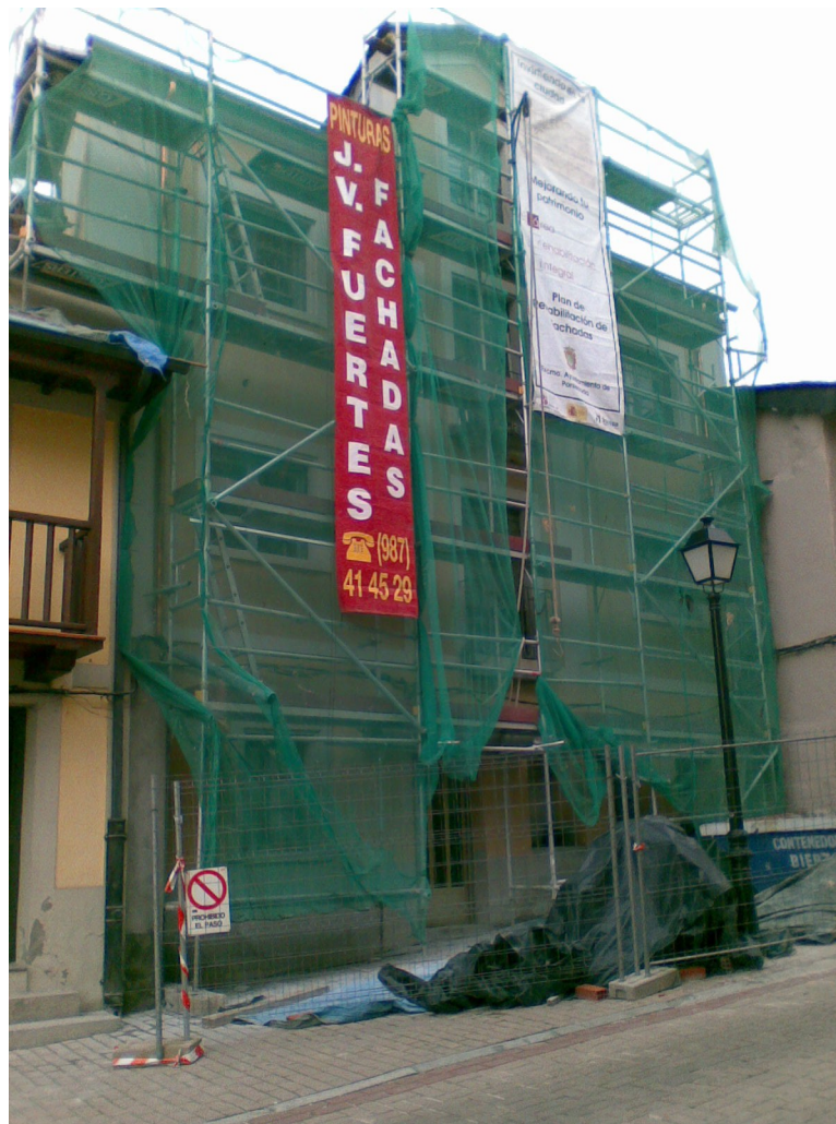
Figura 8.2.- Andamio en fachada.
