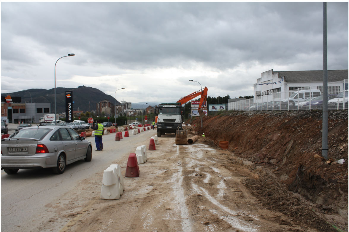
Figura 3.1.- Obra de acondicionamiento de arcenes.
