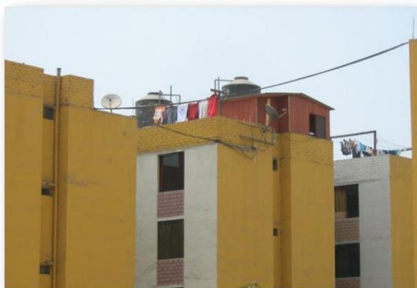
**Figura 1. Construcción no permitida en cubierta Conjunto Residencial en Lima-Perú**
