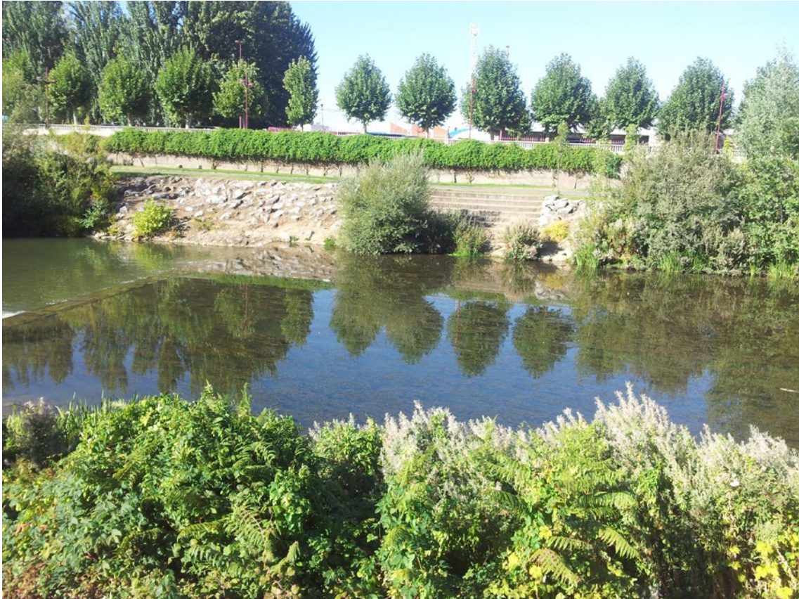
Fotografía 1.6 Río Bernesga a su paso por León, encauzado con escollera de piedras.
