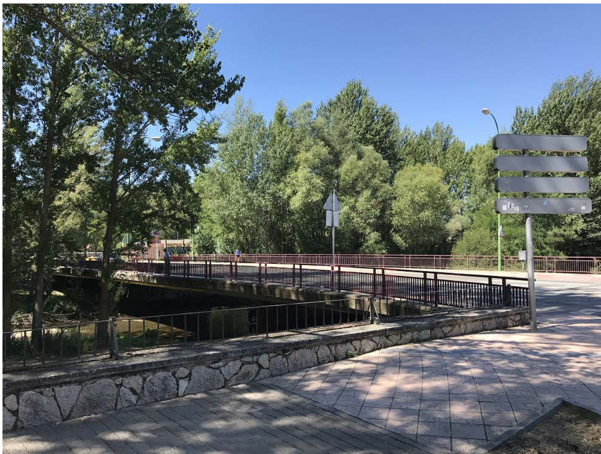
Figura 4.5: Fotografía del Puente de Veterinaria (2017)
