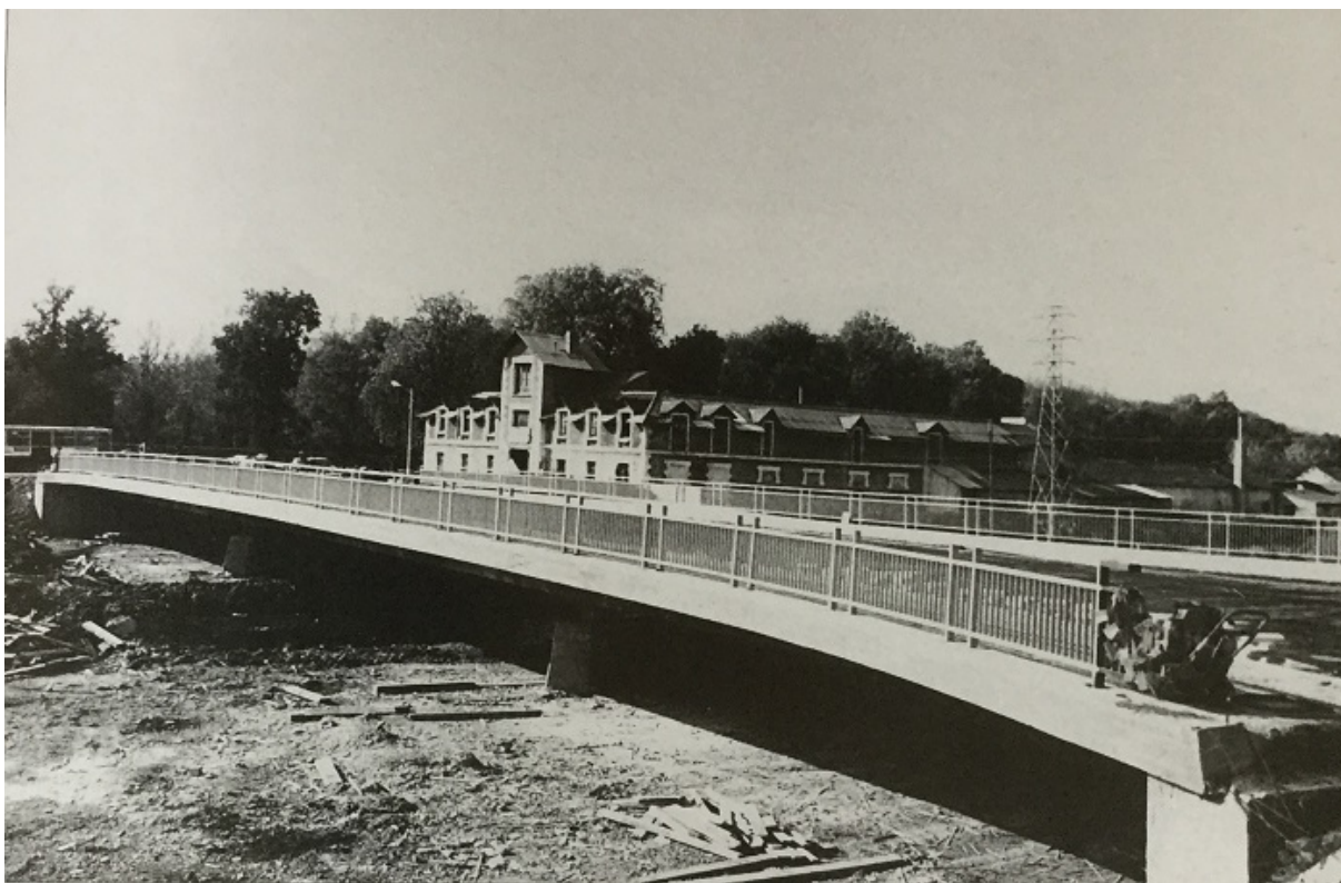
Figura 4.4: Construcción del Puente de Veterinaria (1978)
