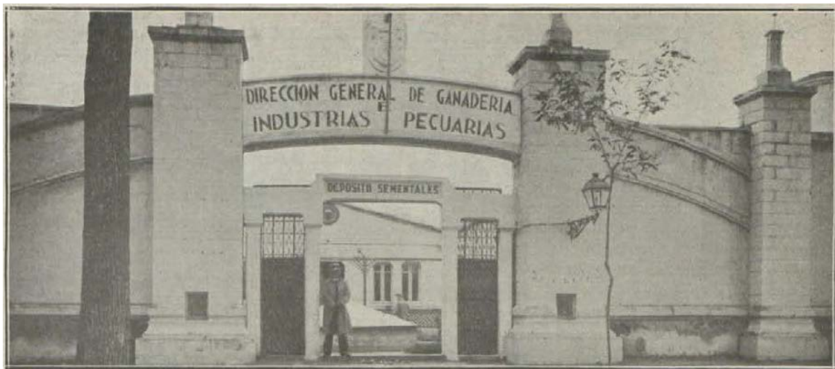
Figura 2.9: Entrada principal del Depósito de Sementales de Burgos (1934)
