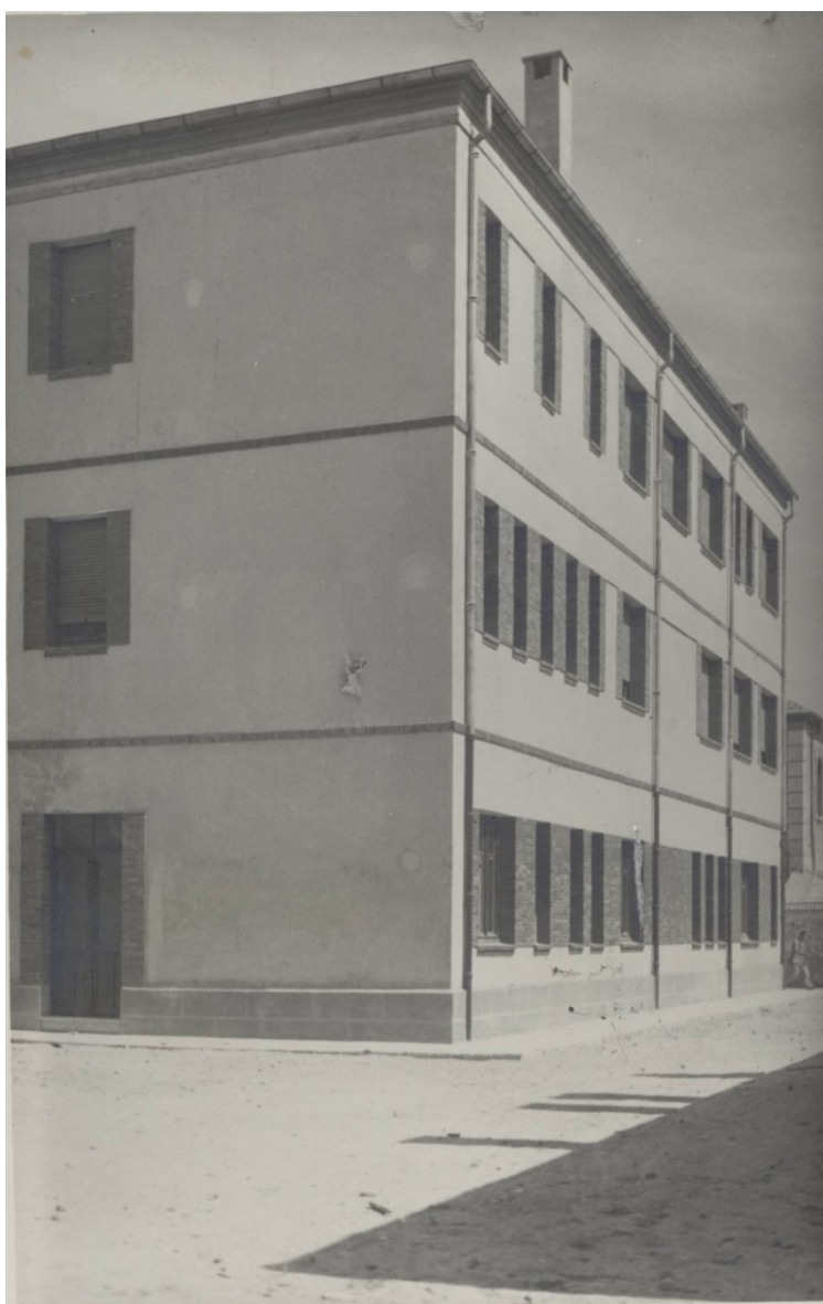
Figura 4.6: Residencia de Suboficiales del cuartel “General Yagüe” (1945)
