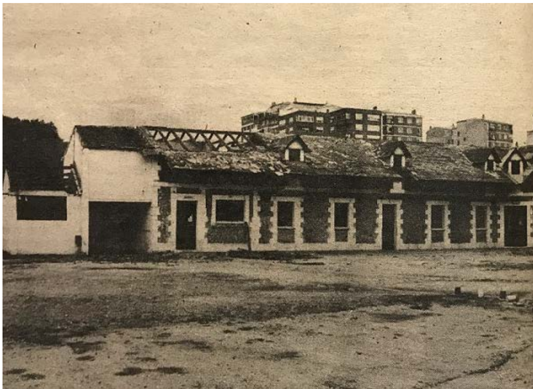
Figura 4.7: Comienzo del derribo del cuartel de Veterinaria
