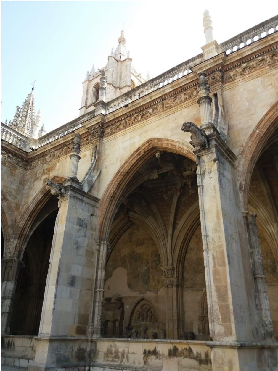
Fig. 16 Vista de detalle de las arquerías del claustro.
