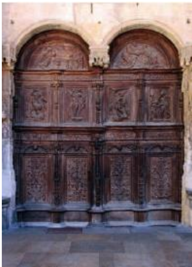
Fig. 24 Puertas de acceso al claustro
