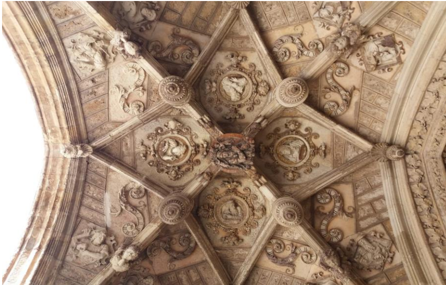
Fig. 17 Detalle de la bóveda del ángulo sur-oeste del claustro
