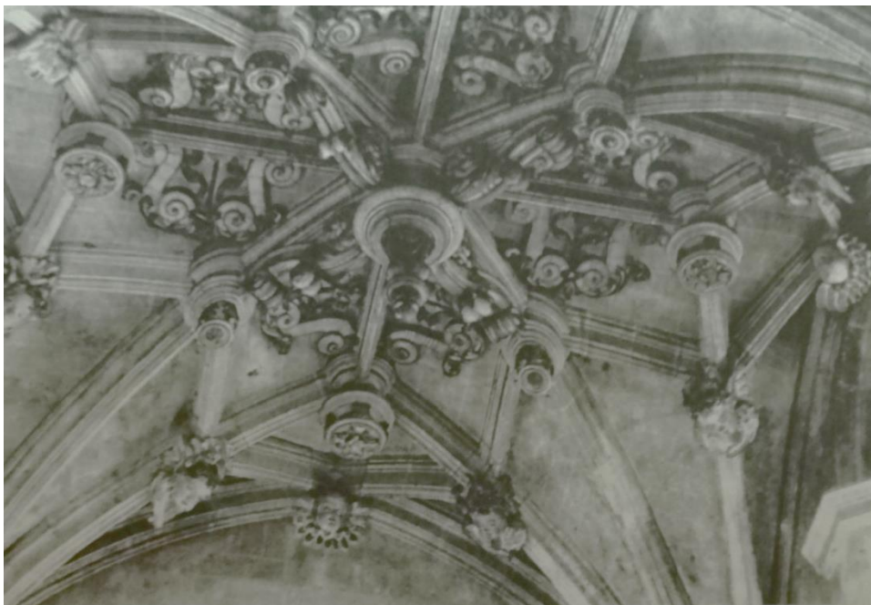
Fig. 22 Detalle de la bóveda de la cabecera del oratorio de la sacristía de la catedral de León
