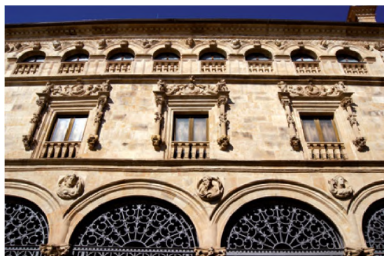
Figura 3. Palacio de La Salina, Salamanca. Detalle de la fachada.
