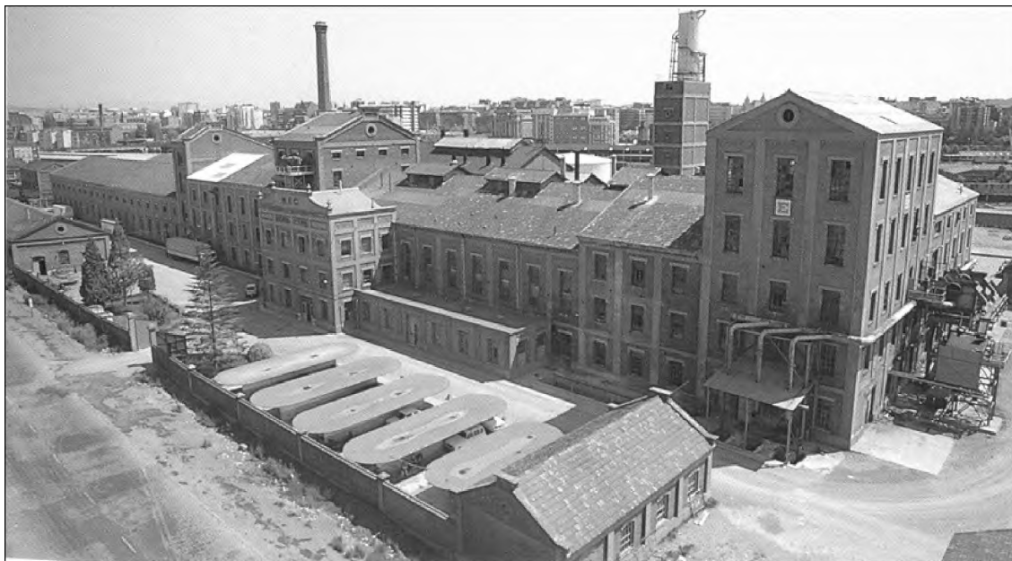
Figura 1: Vista del cuerpo central de edificios de la Azucarera Santa Elvira. Estado actual (foto tomada en junio de 2001).
